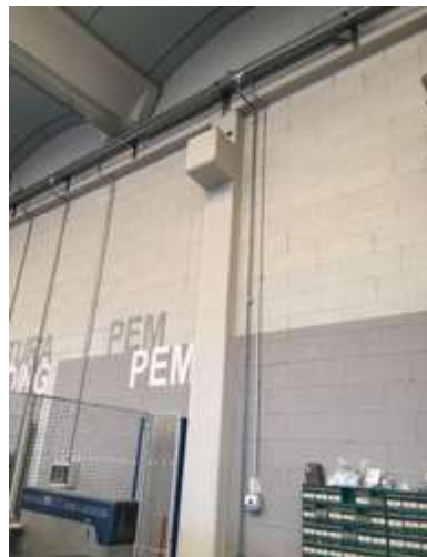
SCHEDA 70 N° INV. 70 IMPIANTO ARIA COMPRESSA, PISTOLE E RACCORDI
