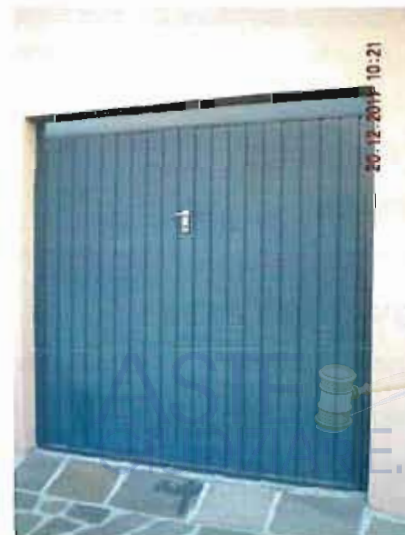
Figura 04: Particolare basculante ingresso garage
