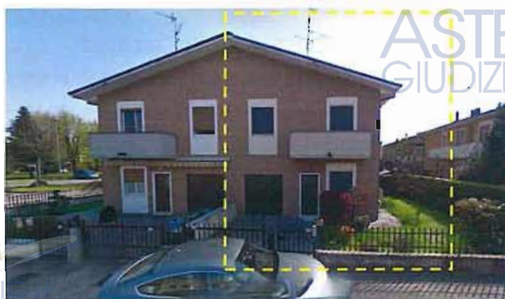
Figura 02: Visione esterna dell'immobile, fronte verso Via Internazionale – lato ovest
