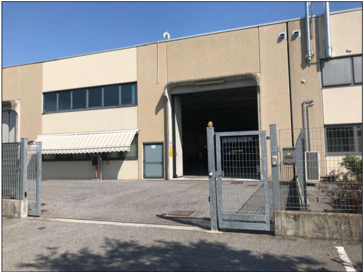
Fotografia 3 – Particolare vista facciata ovest, su via Agostino Gallo
