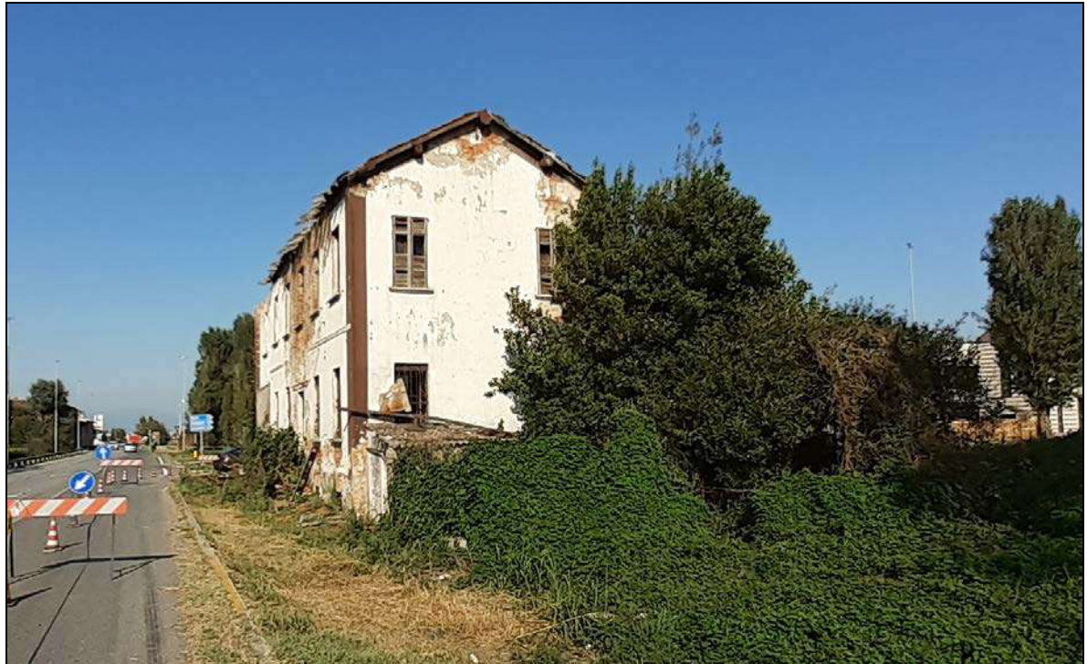
Fotografia 24 – Vista angolo facciata sud - facciata ovest
