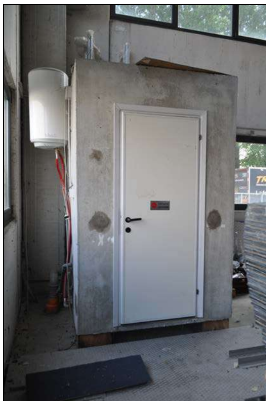
Fotografia 21 – Blocco servizi realizzato dal conduttore
