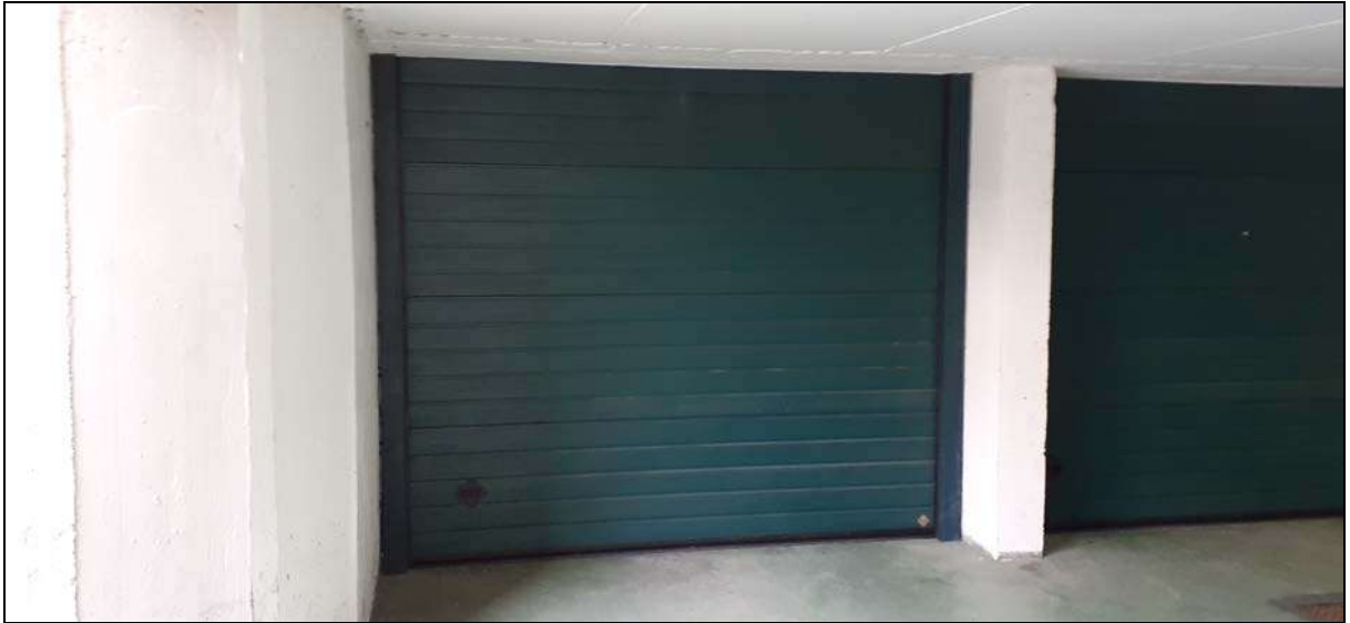
Fotografia 37 – Serranda dell' autorimessa
