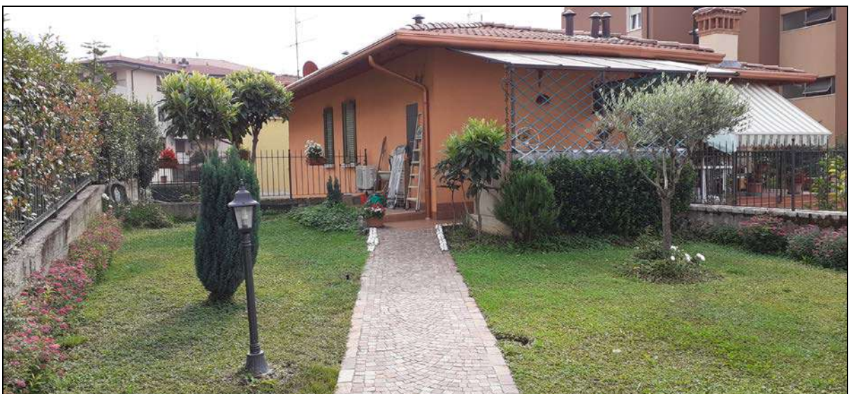
Fotografia 33 – Vista angolo facciata nord – facciata ovest
