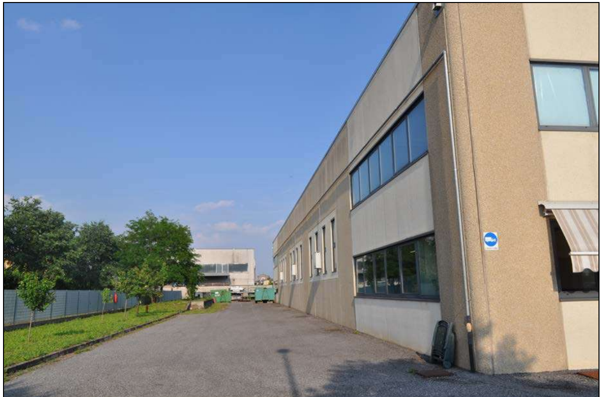
Fotografia 4 – Angolo facciata ovest – facciata nord
