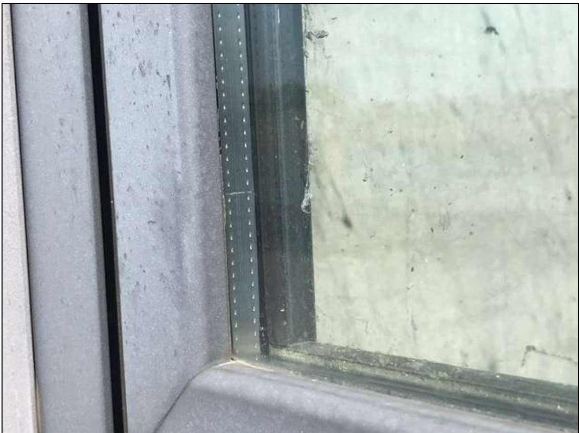
Fotografia 20 – Particolare dei serramenti
