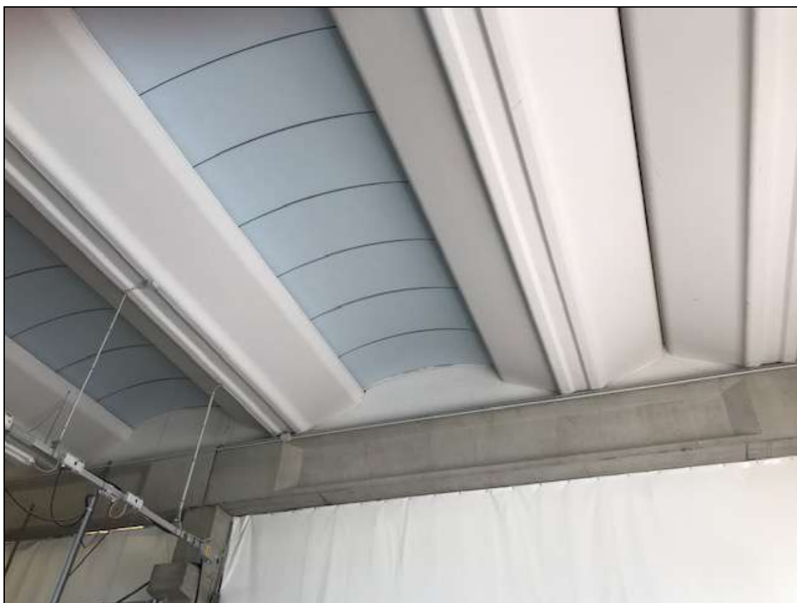
Fotografia 8 – Particolari della copertura
