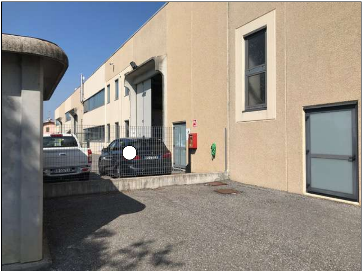
Fotografia 12 – Particolare vista facciata ovest, su via Agostino Gallo
