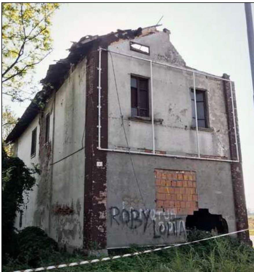
Fotografia 25 – Vista angolo facciata nord - facciata est
