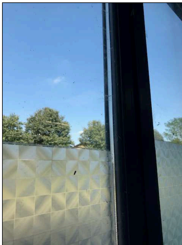
Fotografia 9 – Particolare dei serramenti
