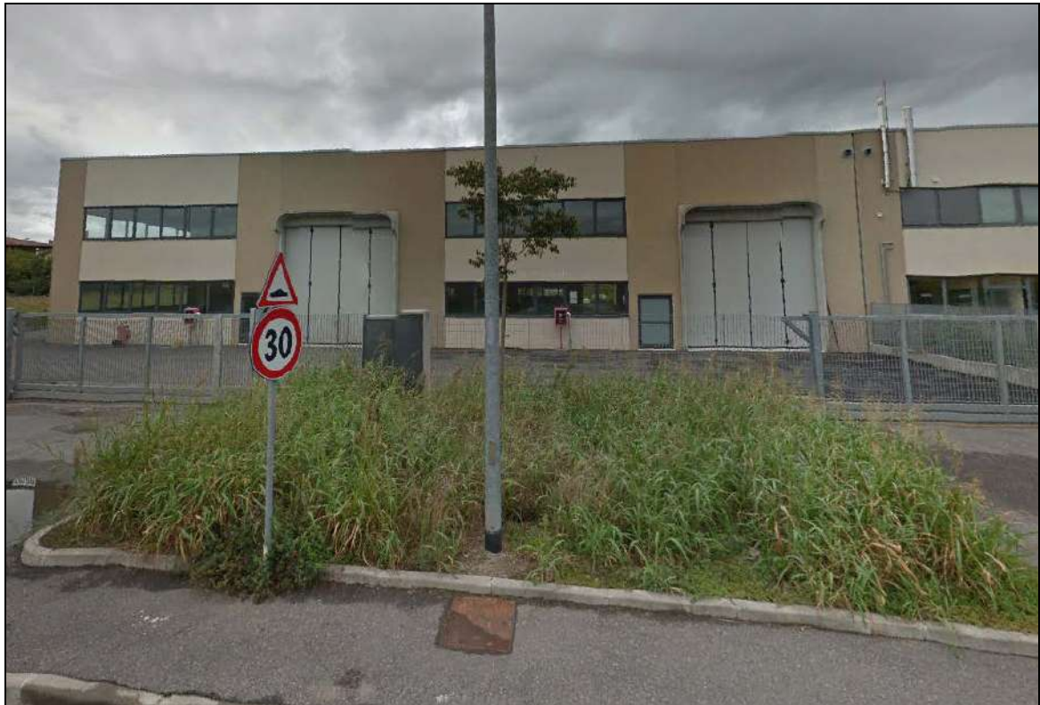
Fotografia 1 – Vista facciata ovest, su via Agostino Gallo
