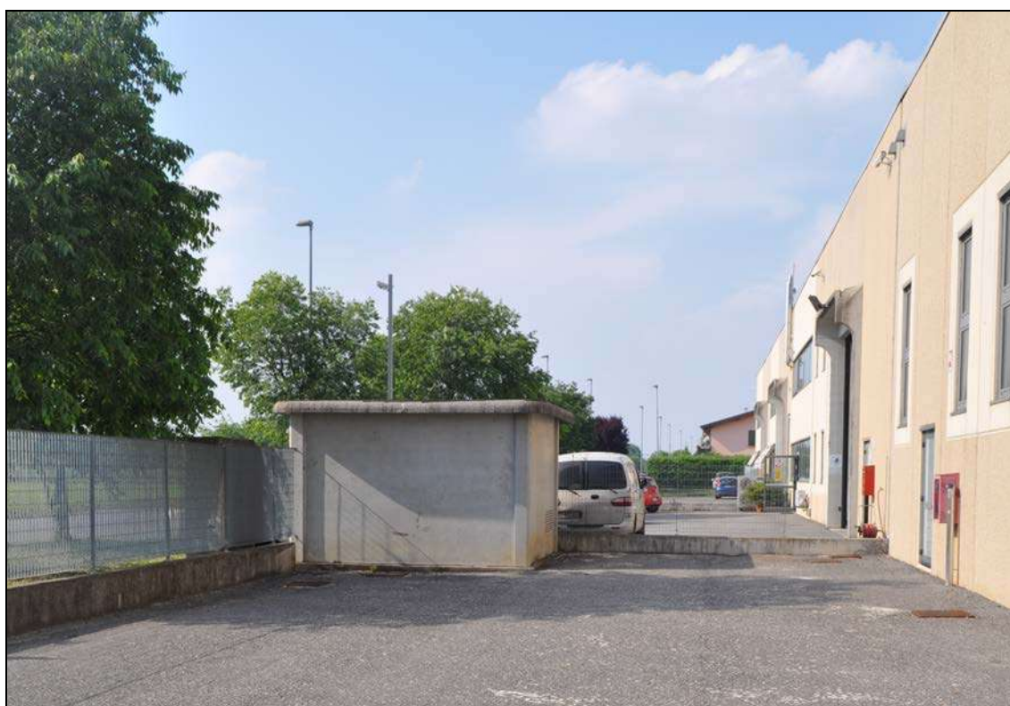
Fotografia 22 – Cabina di trasformazione non interessata dall'esecuzione
