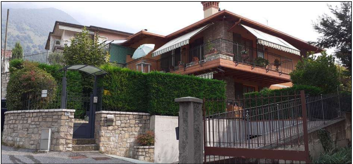
Fotografia 31 – Vista angolo facciata ovest – facciata sud
