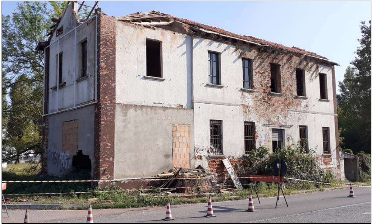
Fotografia 23 – Vista angolo facciata nord - facciata ovest
