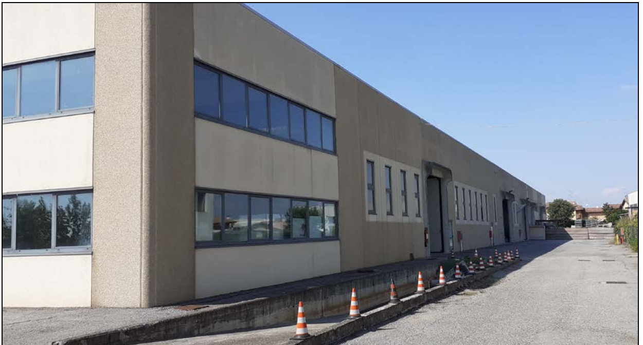
Fotografia 16 – Vista facciata est, sulla destra rampa di scarico automezzi
