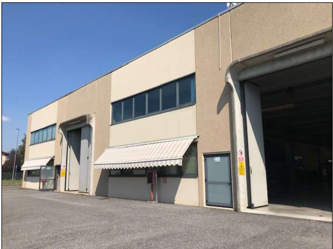
Fotografia 2 – Particolare vista facciata ovest, su via Agostino Gallo
