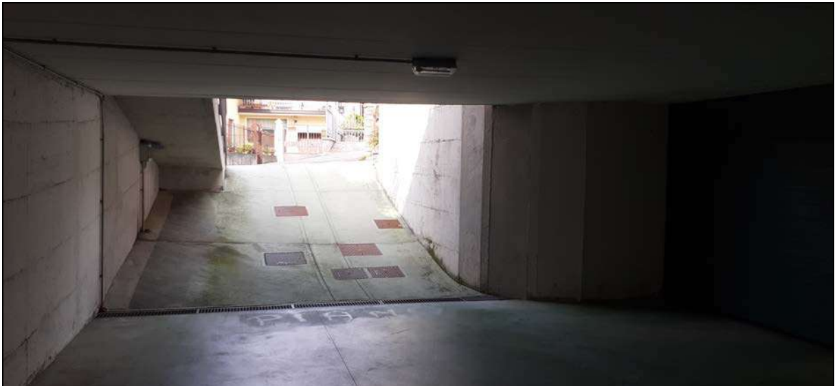
Fotografia 35 – Vista rampa di accesso alle autorimesse
