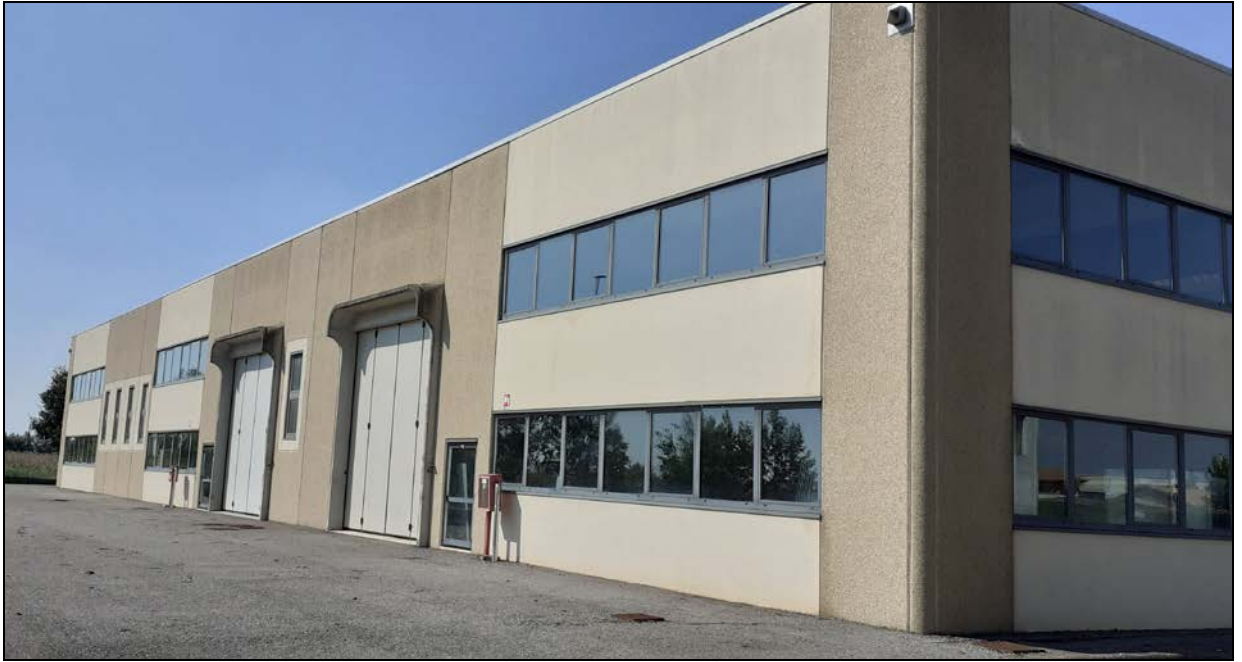
Fotografia 15 – Vista facciata sud, su via X Giornate
