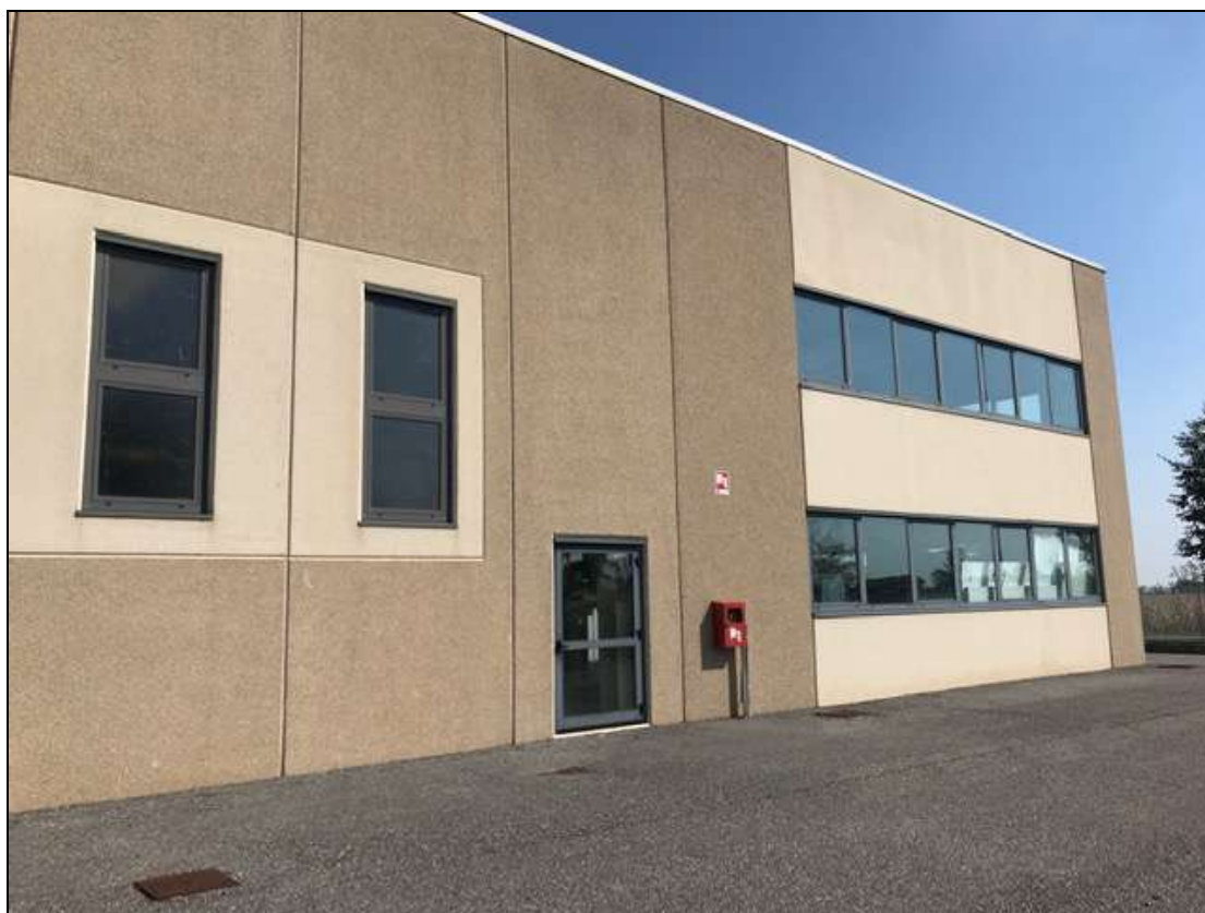
Fotografia 14 – Particolare vista facciata ovest, su via Agostino Gallo
