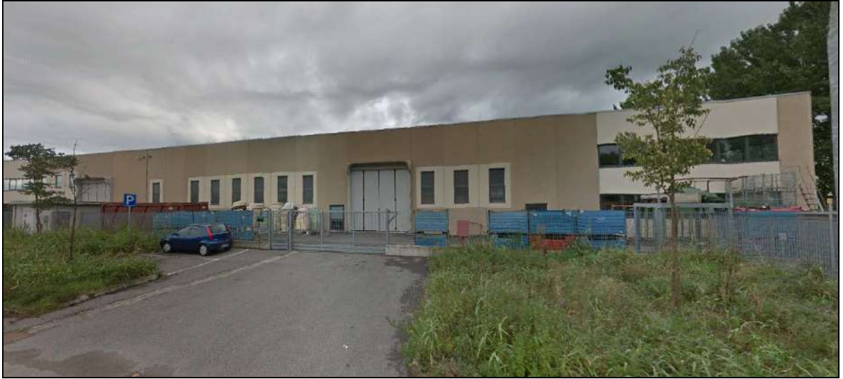
Fotografia 11 – Vista facciata ovest, su via Agostino Gallo
