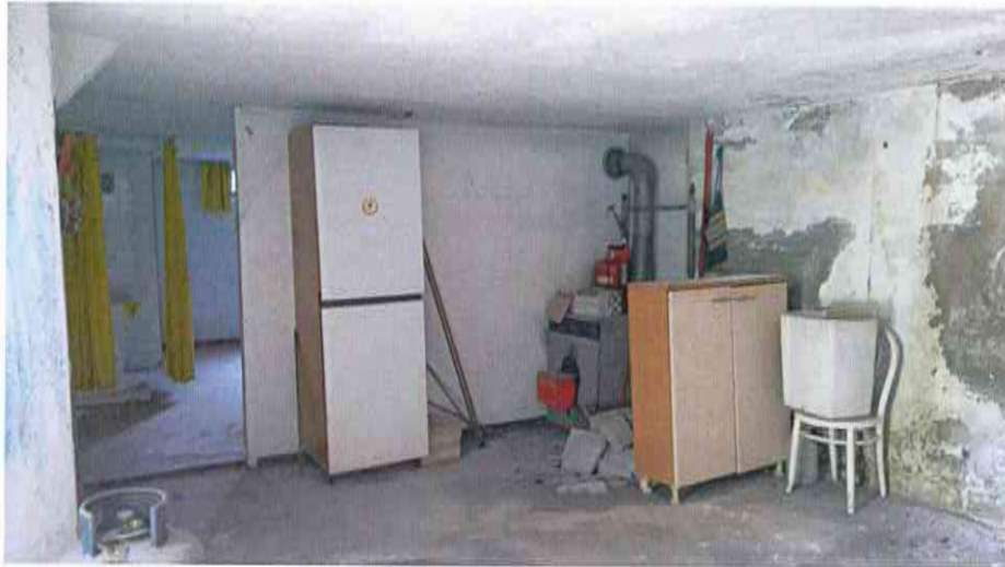
(il vano box- zona caldaia.)
