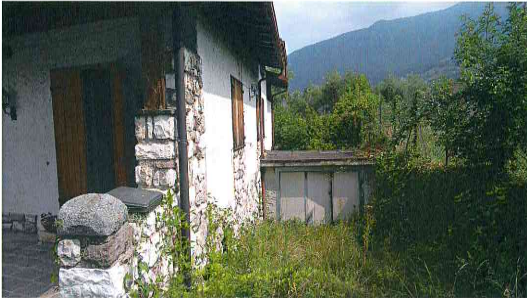
(La rampa e il fronte ingresso autorimessa)
