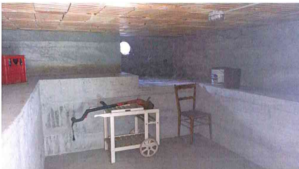
(La parte di cantina di più recente realizzazione)
