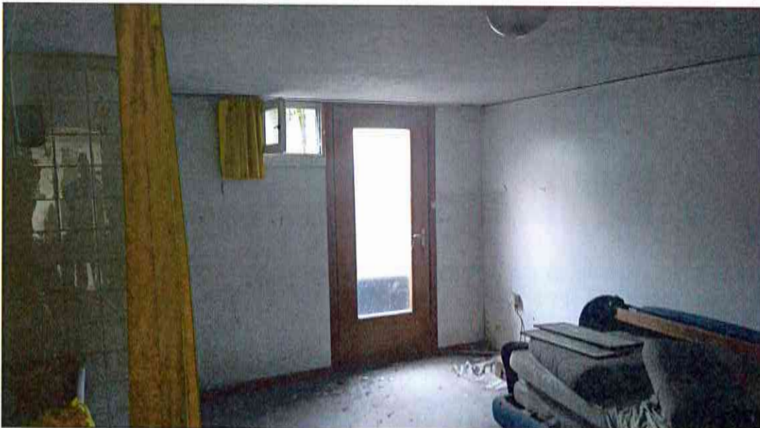
(la zona ripostiglio/lavanderia)
