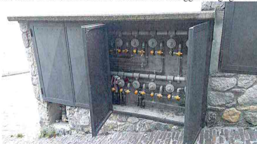
(vano contatori metano)
