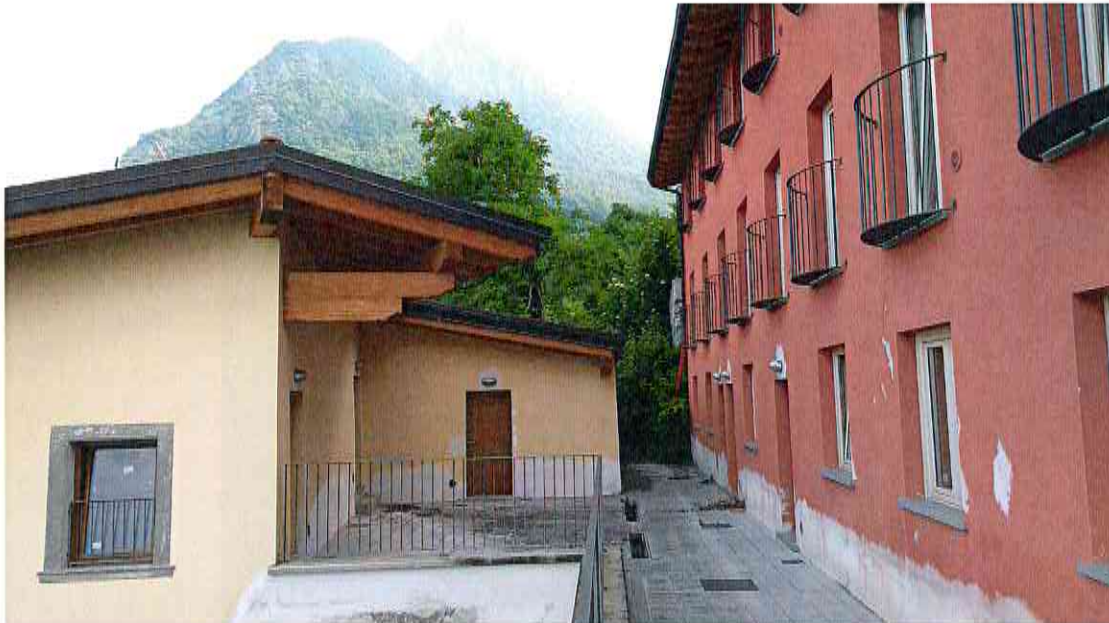
(fronte ovest del fabbricato alto-cortile accesso)
