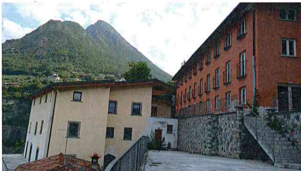
(vista d'insieme dei due corpi di fabbrica)
