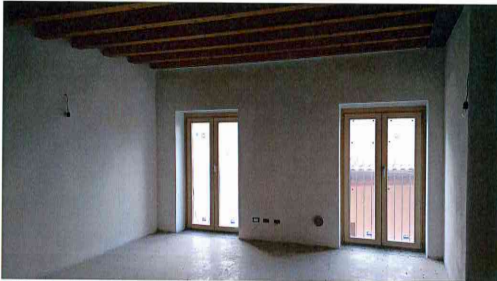
(interno di un appartamento piano primo)
