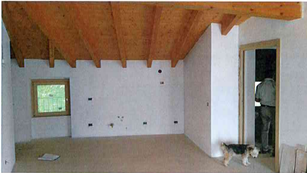
(interno di un appartamento piano secondo-mansarda)
