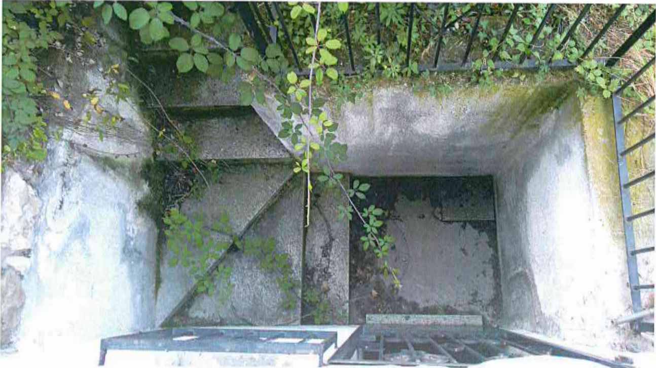
(la scaletta che porta al piano interrato)
