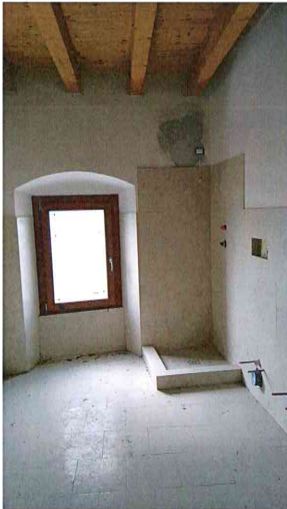
(interno di un locale bagno al piano primo)
