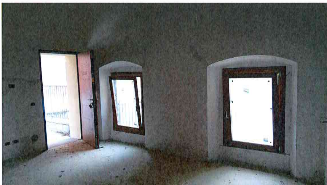
(interno di un appartamento piano secondo-mansarda)
