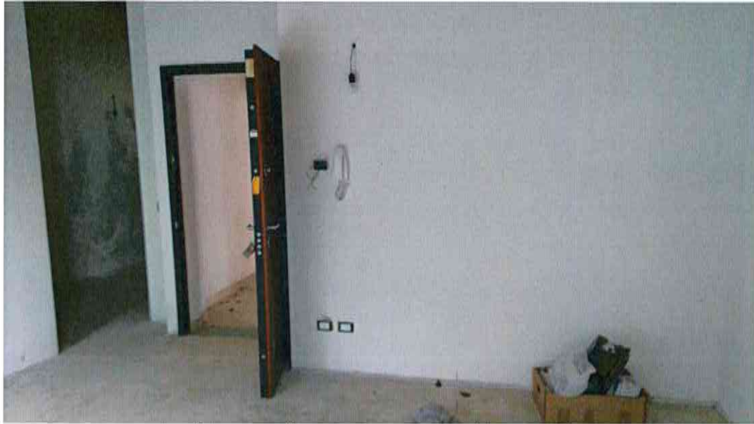
(ingresso di un appartamento piano terra)
