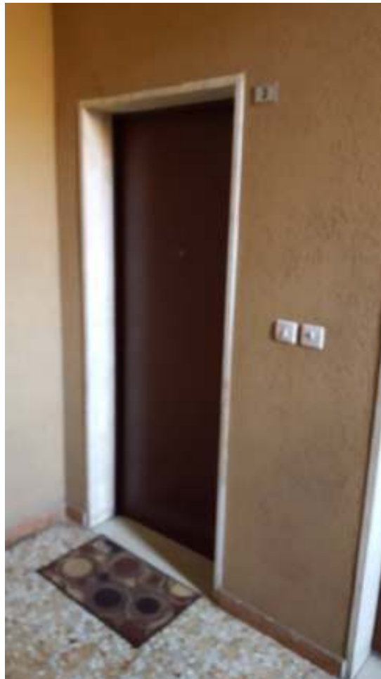
02 – VISTA PORTONCINO DI INGRESSO ALLOGGIO
