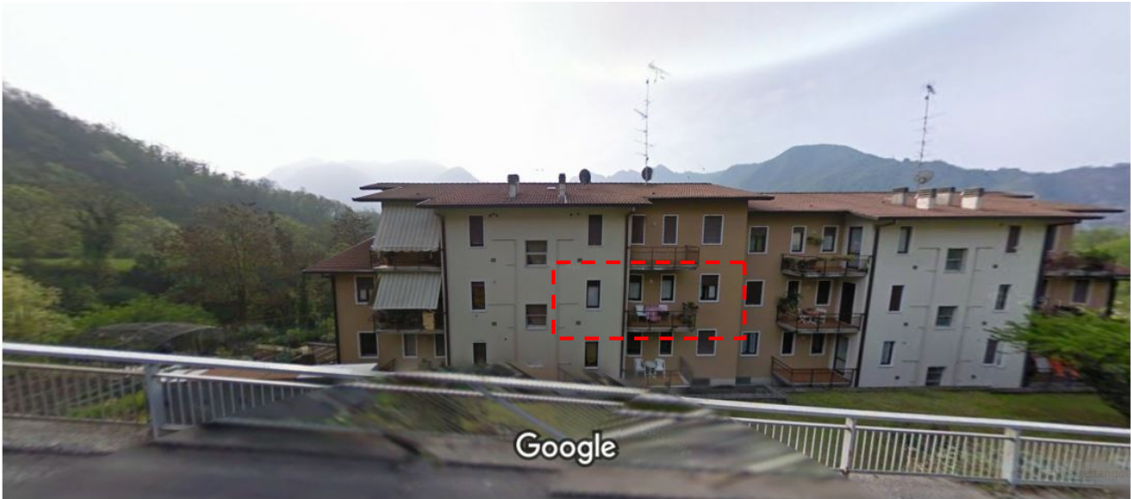
Fig. 21 Fotografia dalla strada verso NORD.
