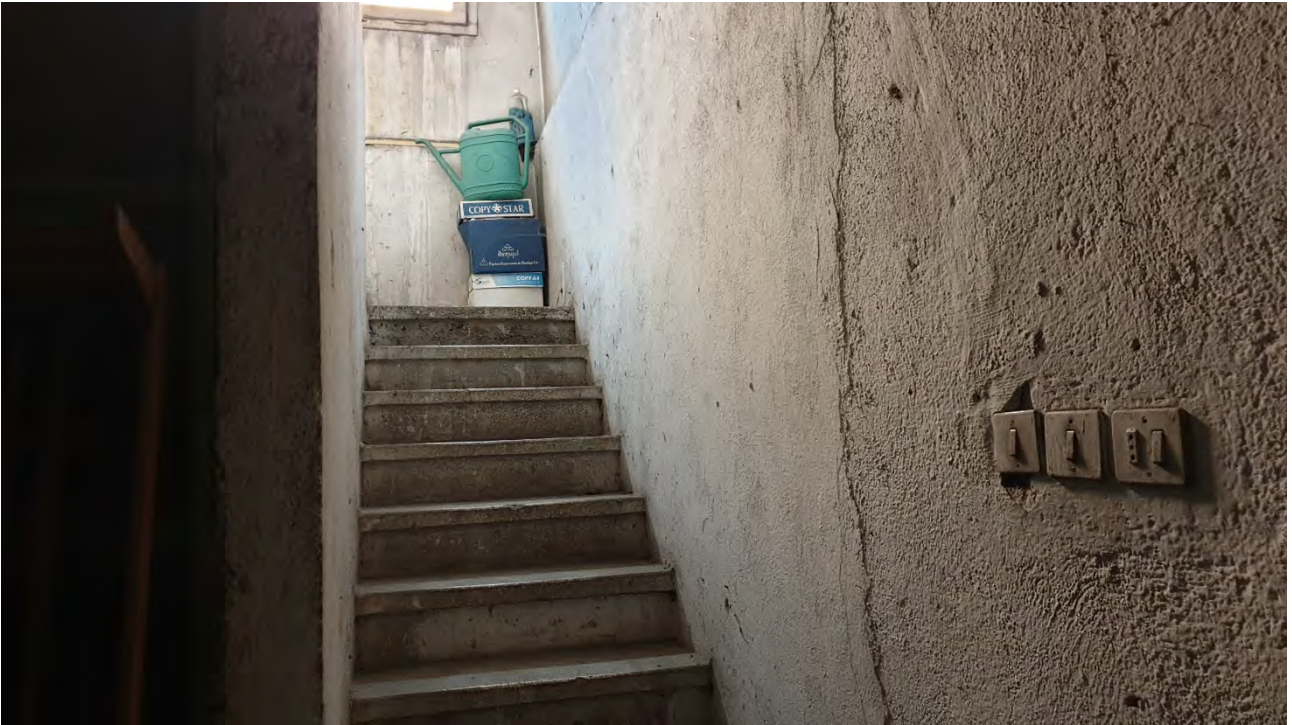
VISTA SCALA PIANO INTERRATO
