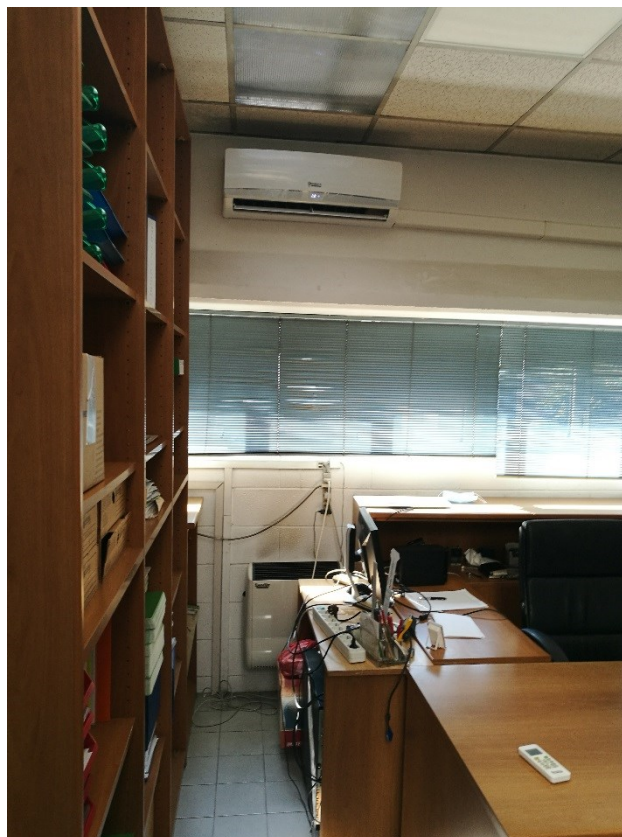
Figura 10: vista ufficio piano primo
