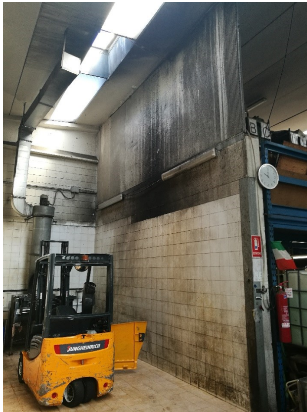
Figura 12: vista area lavaggio
