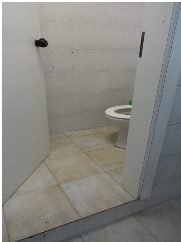
FOTOGRAFIA N. 31 – LOCALE NEGOZIO ESPOSIZIONE – SERVIZIO
