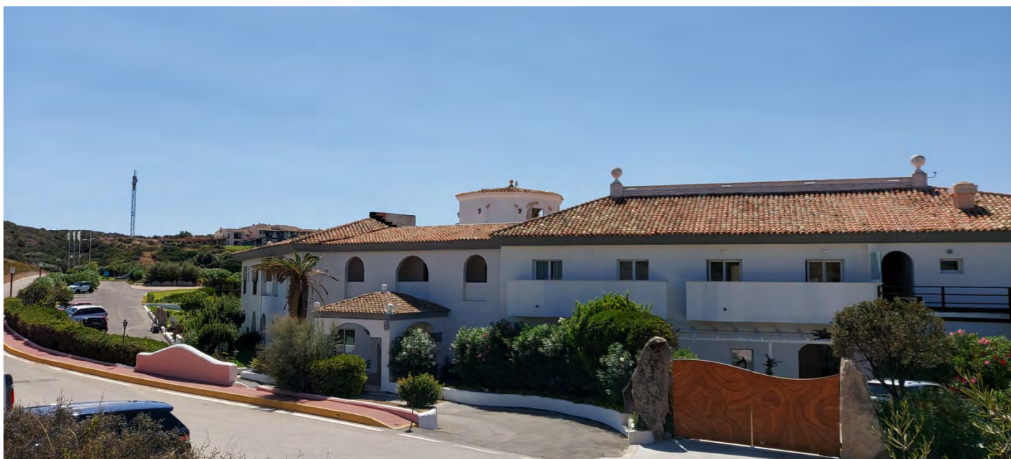
Fotografia N. 05 – Edificio dalla strada comunale, a sinistra il portico di ingresso al ristorante/bar, con soprastanti le arcate di alcune UI al Piano Primo, a destra a fianco del parapetto in legno, il balcone del Sub 415
