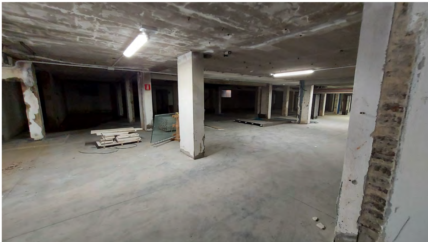
Fotografia N. 19 – Interrato da suddividere
