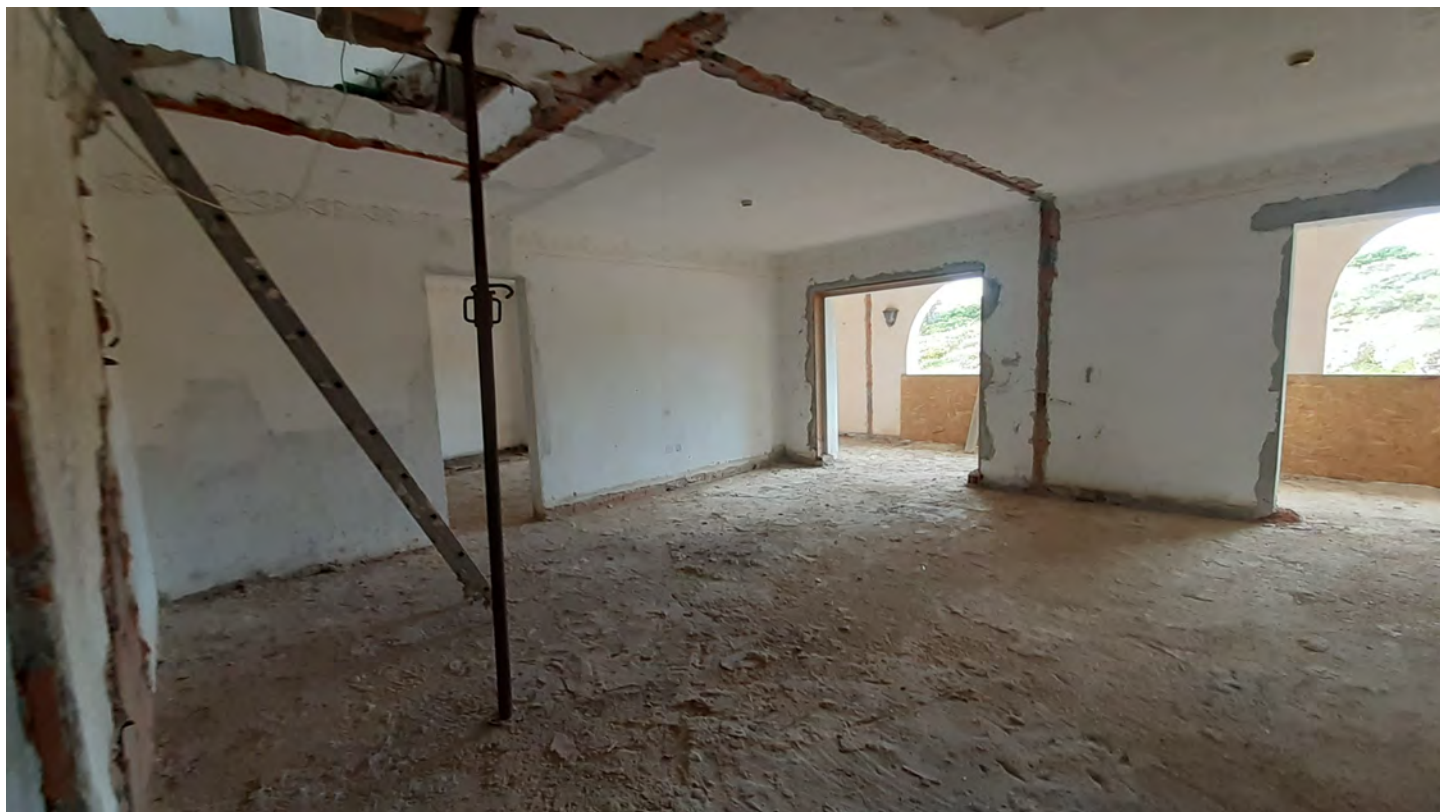
Fotografia N. 13 – Sub 417 Piano Primo con attuale apertura per il Piano Secondo, da modificare
