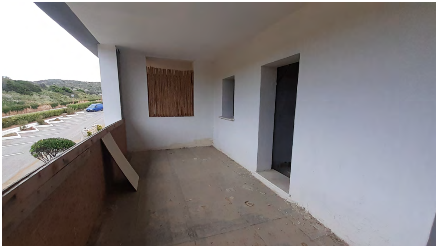
Fotografia N. 9 – Terrazzo lato strada di uno dei Subalterni da frazionare
