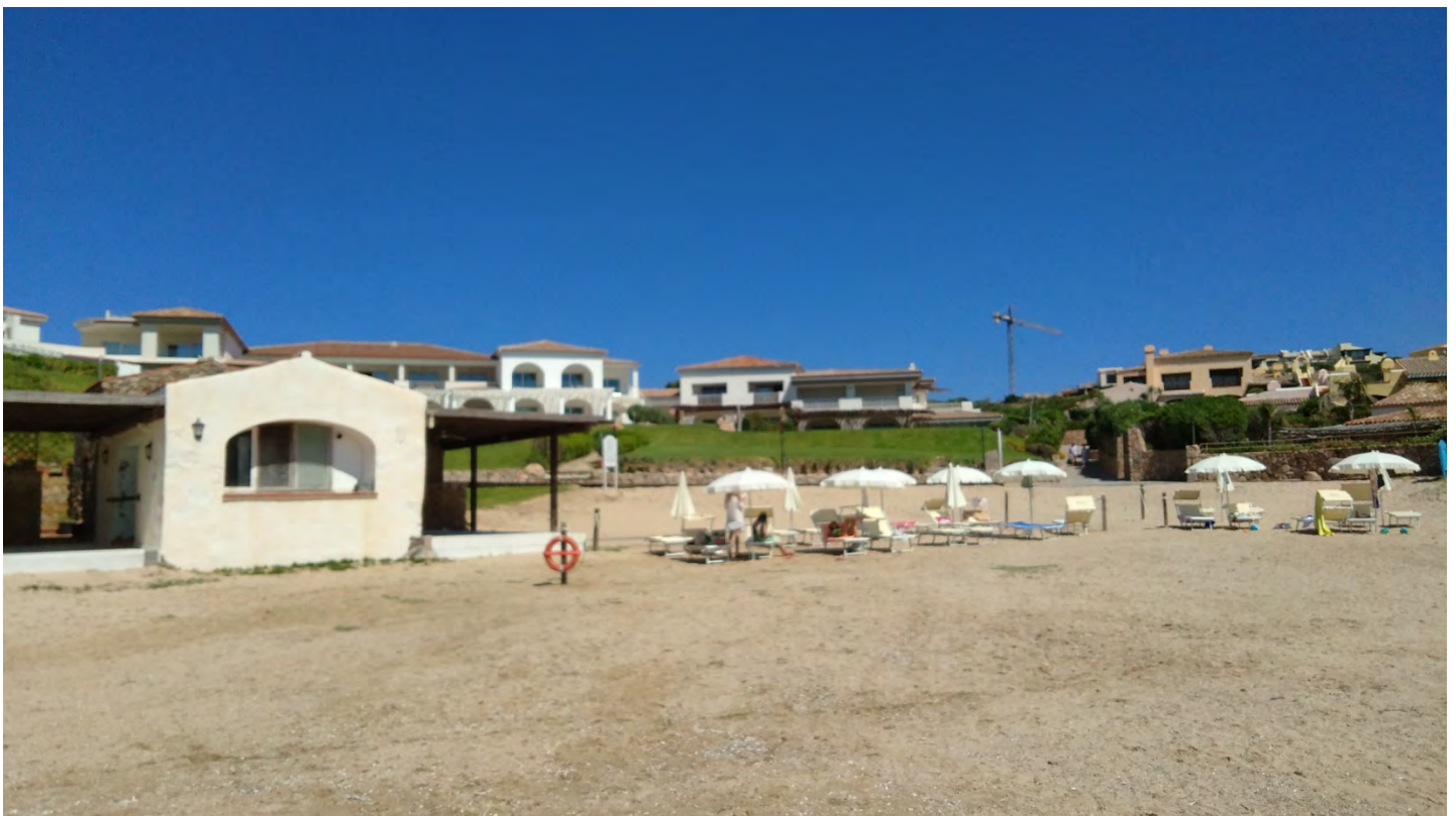
Fotografia N. 02 – Edificio con le U.I. di proprietà del Fallimento dalla spiaggia piccola di Cala del Faro
