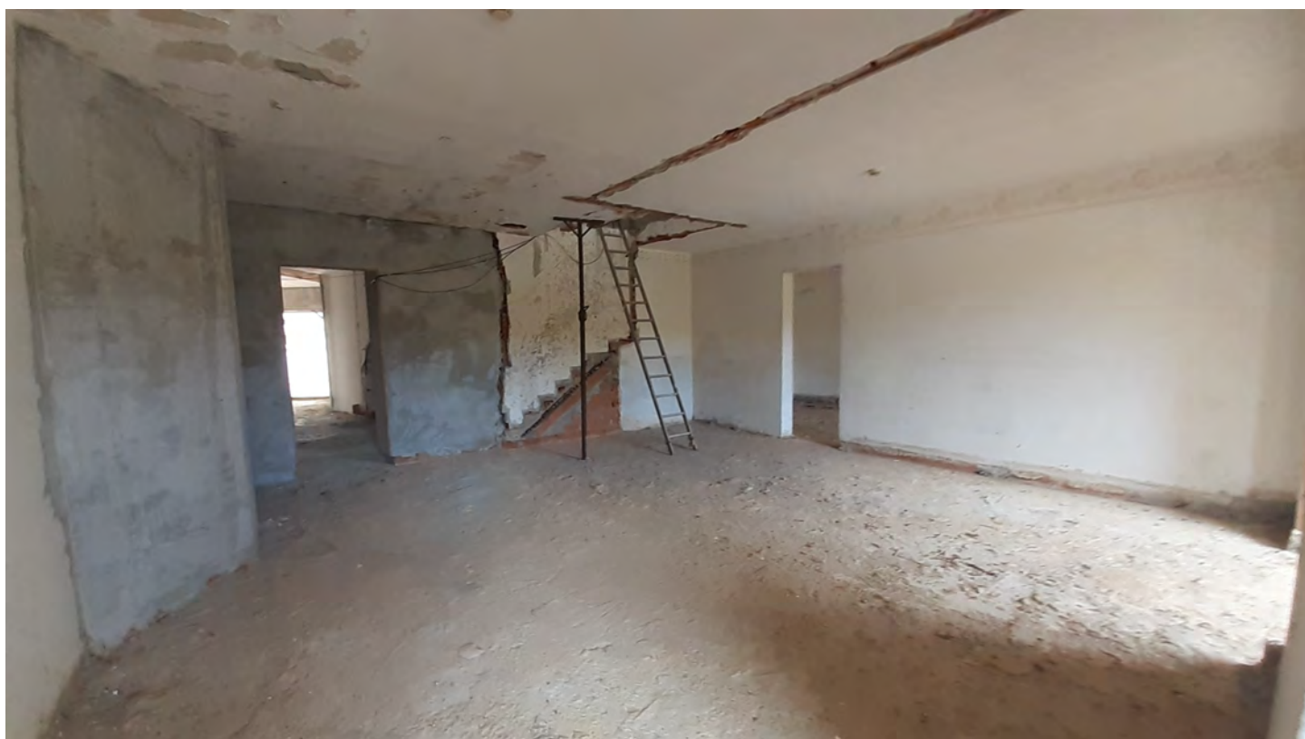
Fotografia N. 14 – Sub 417 Piano Primo con attuale apertura per il Piano Secondo, da modificare
