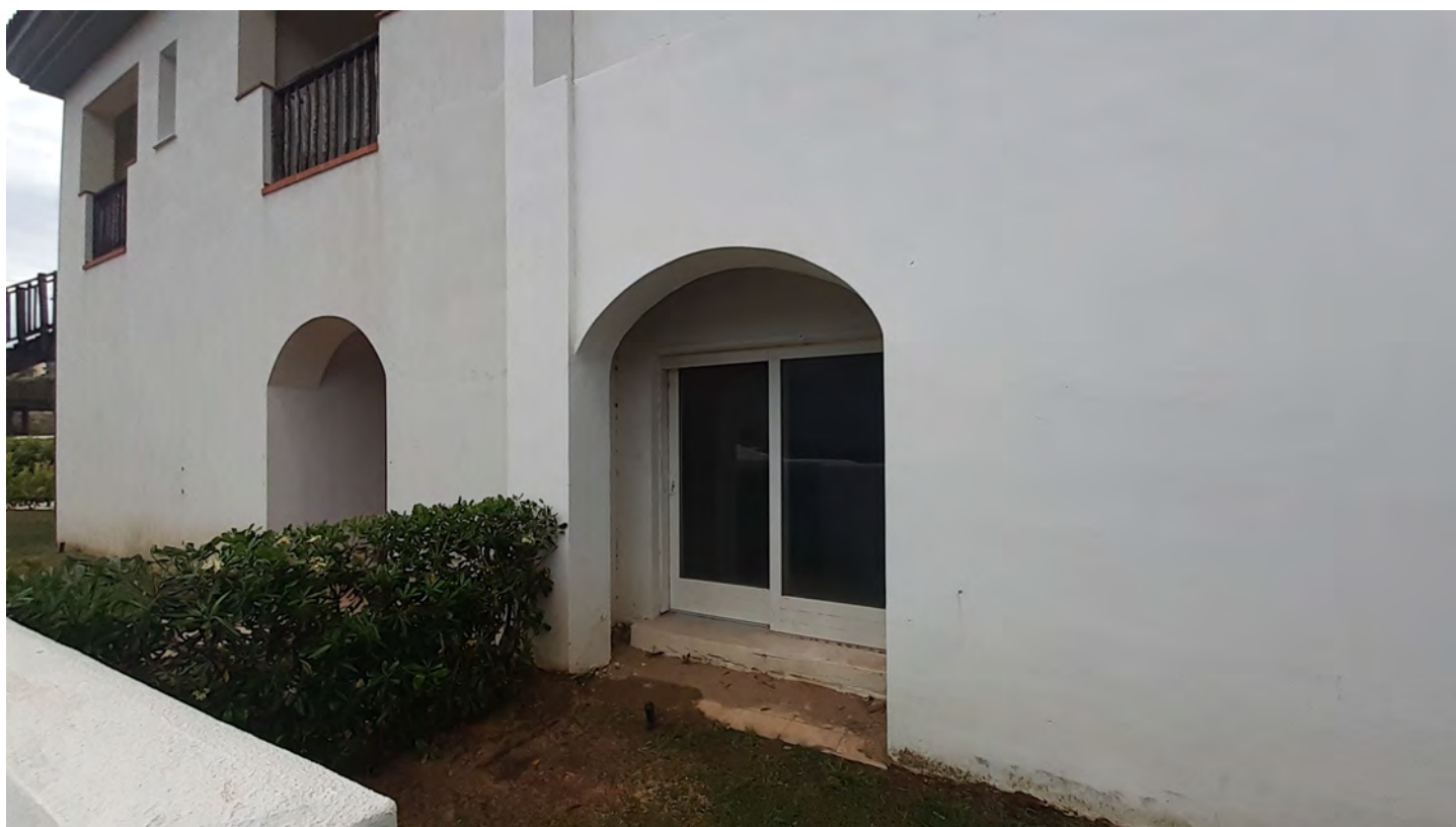
Fotografia N. 16 – Esterno Sub 426 al Piano Terra
