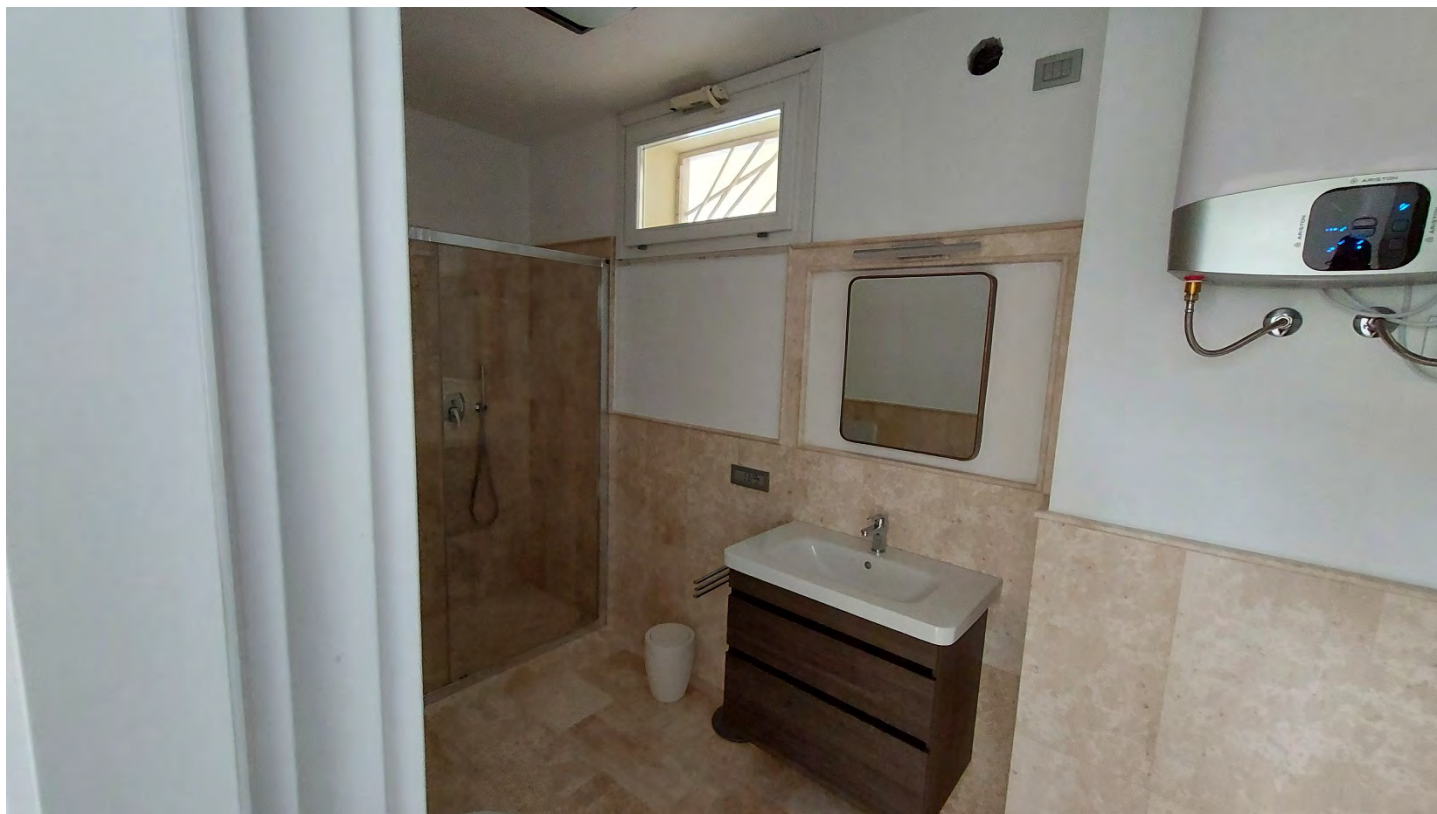
Fotografia N. 07 – Bagno del Sub 415 con luce autorizzata sul Sub 208
