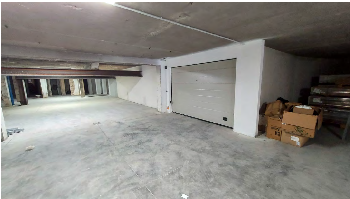
Fotografia N. 20 – Interrato tunnel e portone sezionale di accesso al Sub 257
