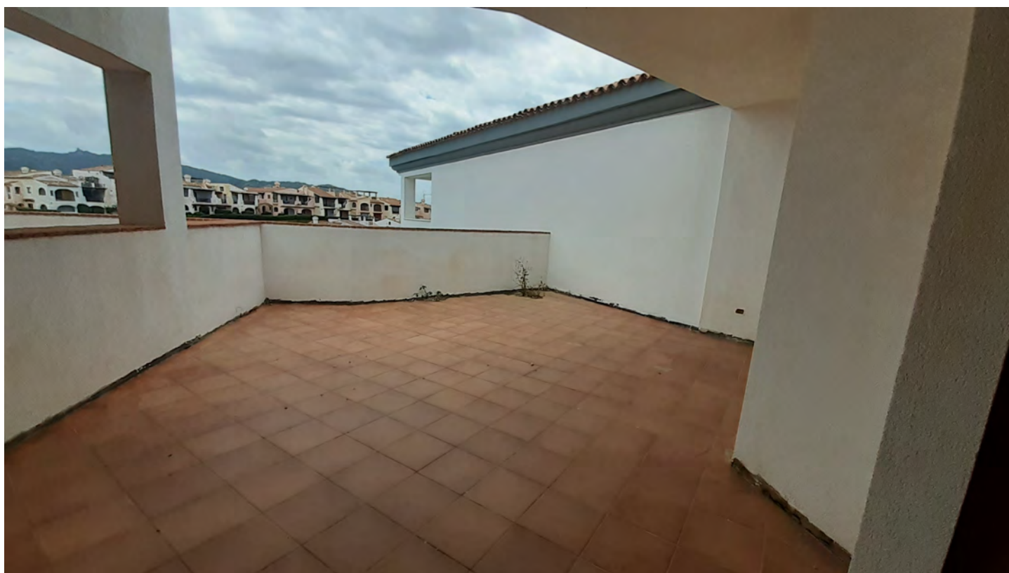
Fotografia N. 12 – Terrazza ristorante al Piano Primo
