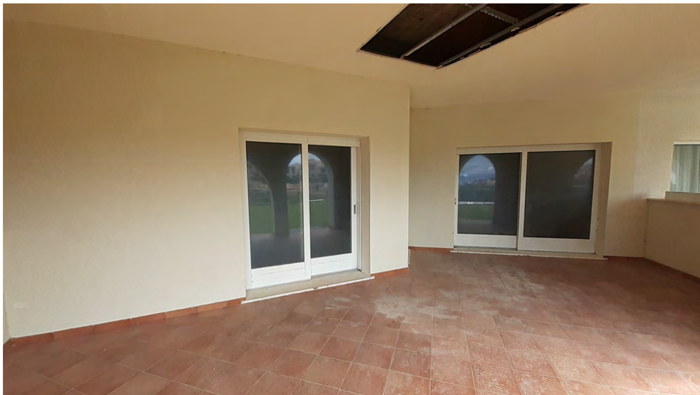
Fotografia N. 17 – Portico lato mare Sub 430 al Piano Terra
