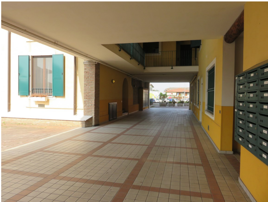
Fig. 06 – Interno androne comune di ingresso
