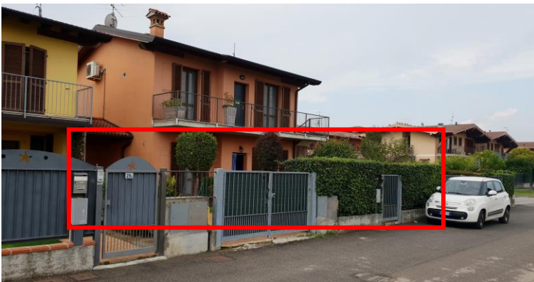
FOTO 5: Ripresa fotografica esterna, fronte principale
