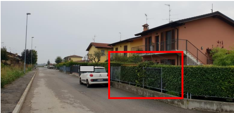
FOTO 4: Ripresa fotografica esterna, fronte principale
