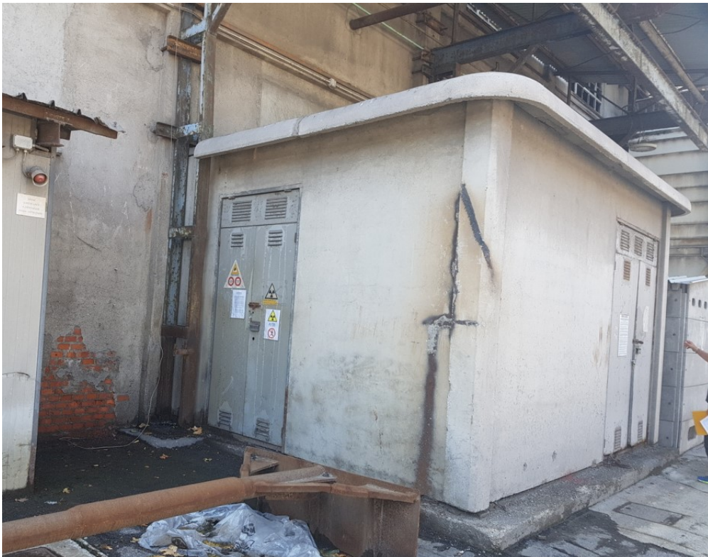
Bunker rifiuti radioattivi di Castel Mella
