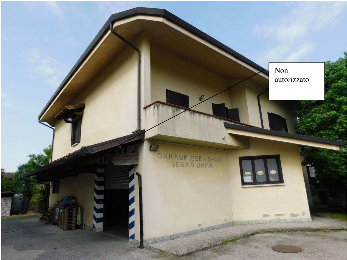
Tettoia non autorizzata
