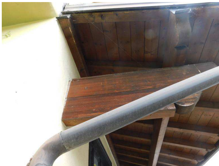
Tettoia non autorizzata (cedimenti)
