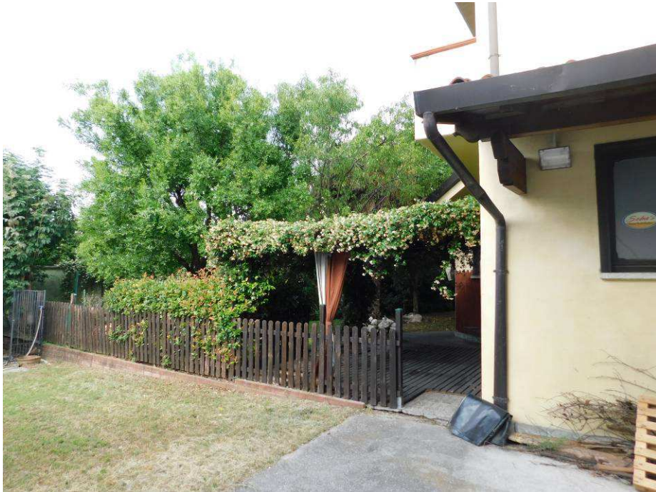
Manufatto (pensilina) esterna non autorizzata
