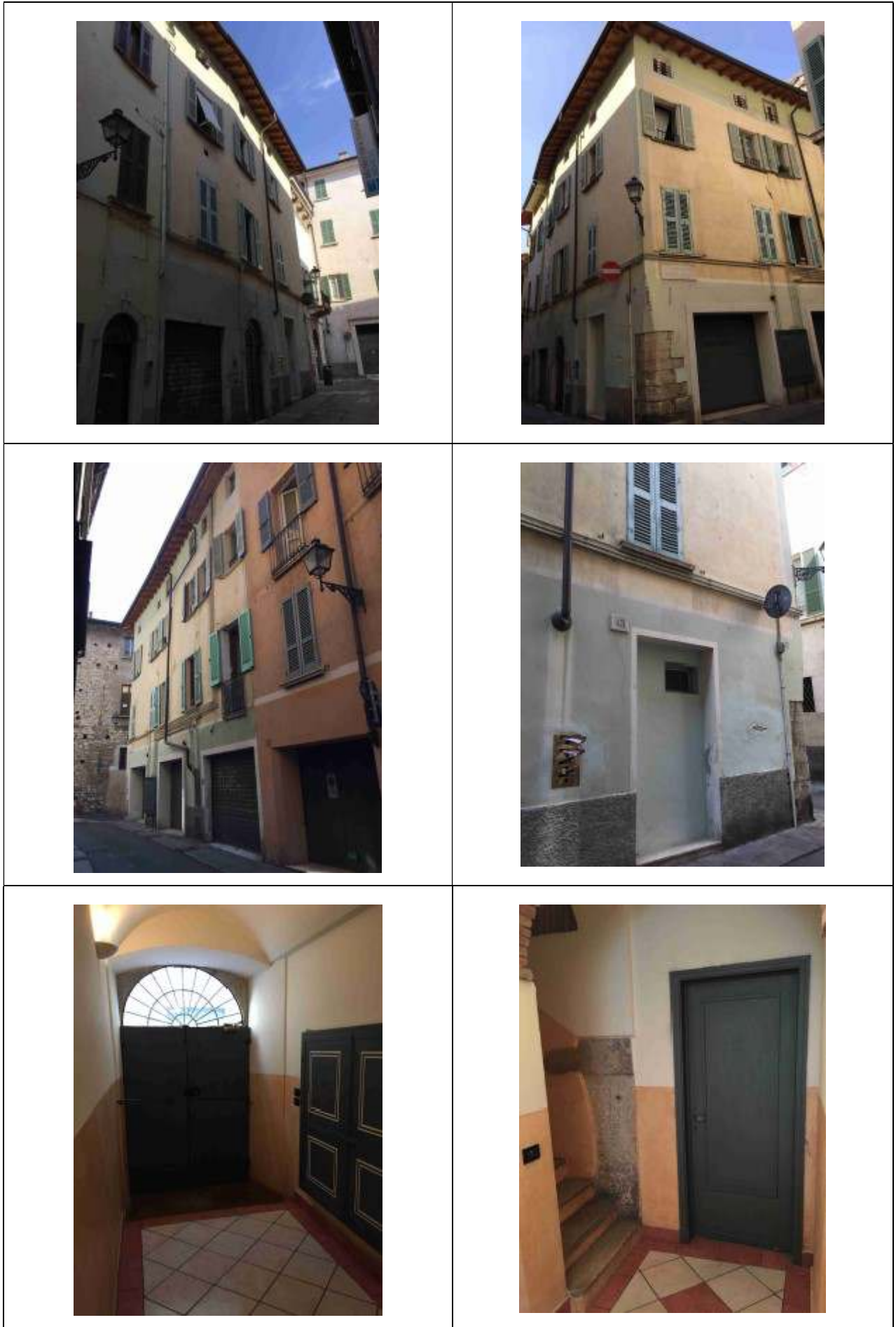
Figura 03:Viste di insieme del fabbricato
