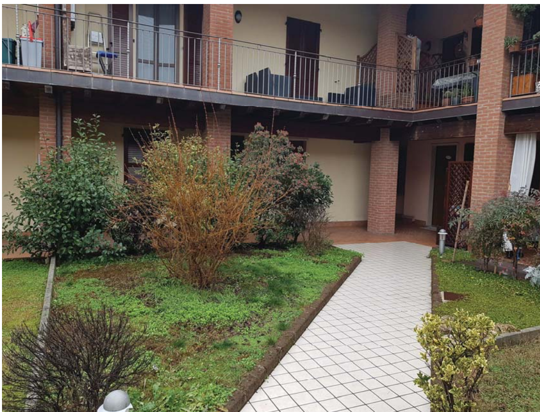
Fronte ingresso - lato est
