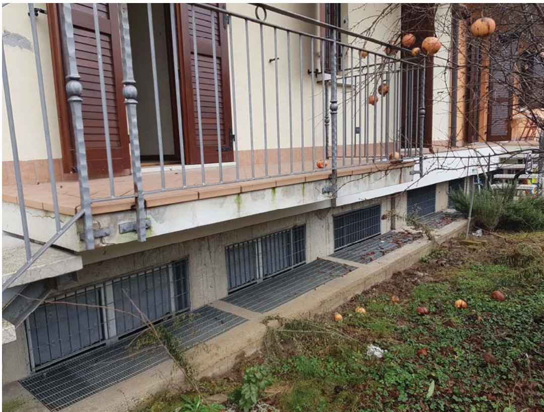
Retro - lato ovest
