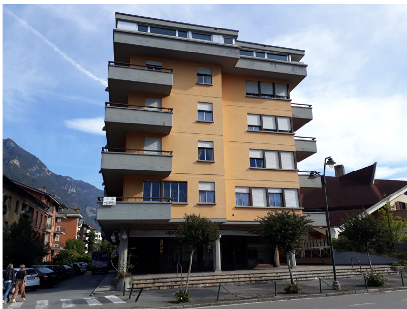
Fabbricato denominato "condominio Elianna" - vista dalla pubblica strada Viale Repubblica
