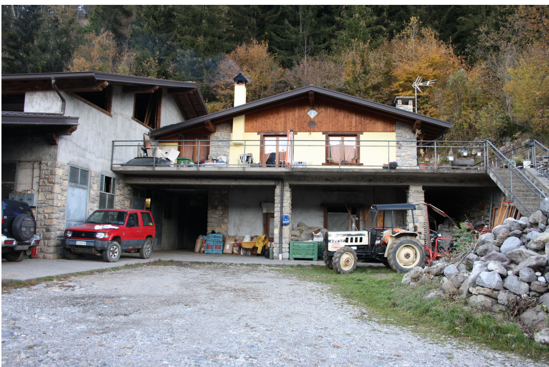
Foto nr.02 – Edificio attiguo adibito a deposito e locali personale
