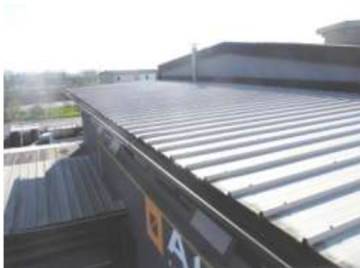
copertura ampliamento a nord
