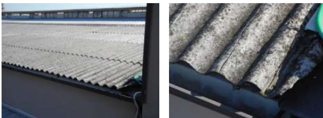
copertura ad ovest
