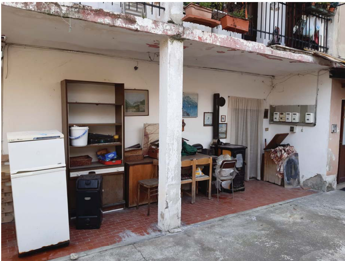
ALL. 32 Fronte prospetto sub. 8 Lotto 3
