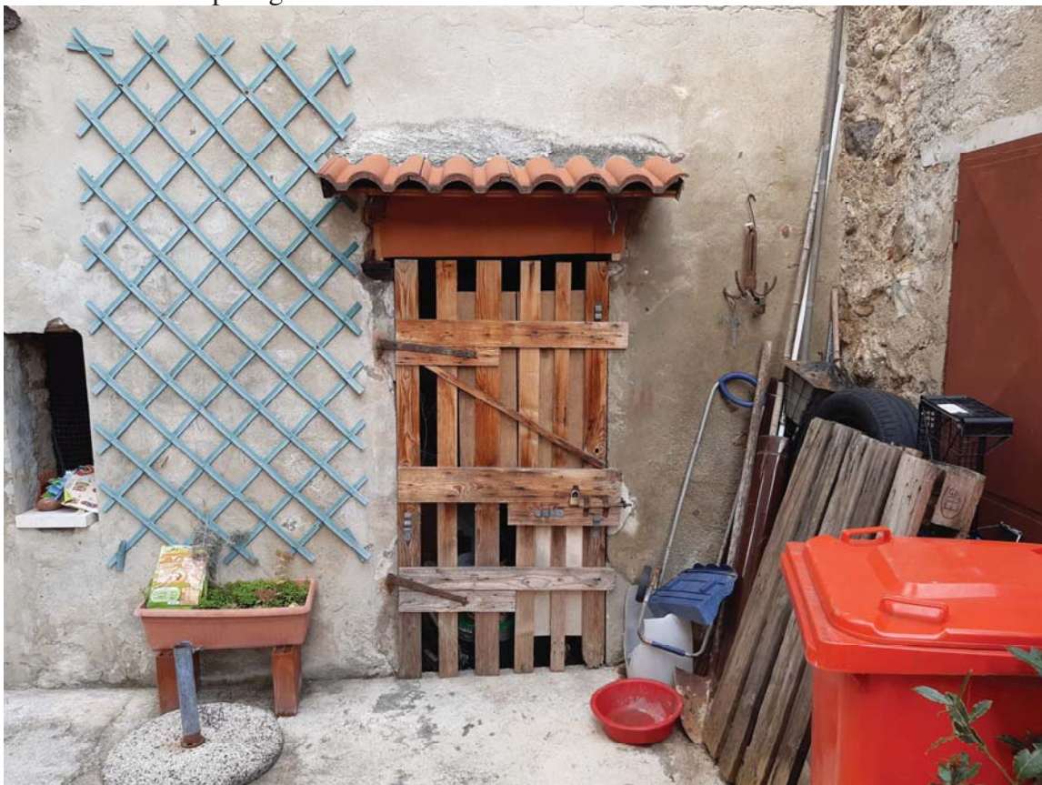
ALL. 31 Fronte ripostiglio comune Lotto 3
