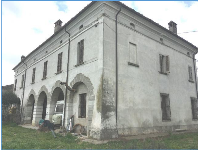
Foto n. 1 – prospetto sud, est
