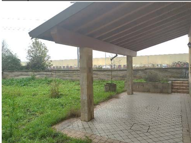
Portico lato ovest adiacente alla residenza sub. 19
