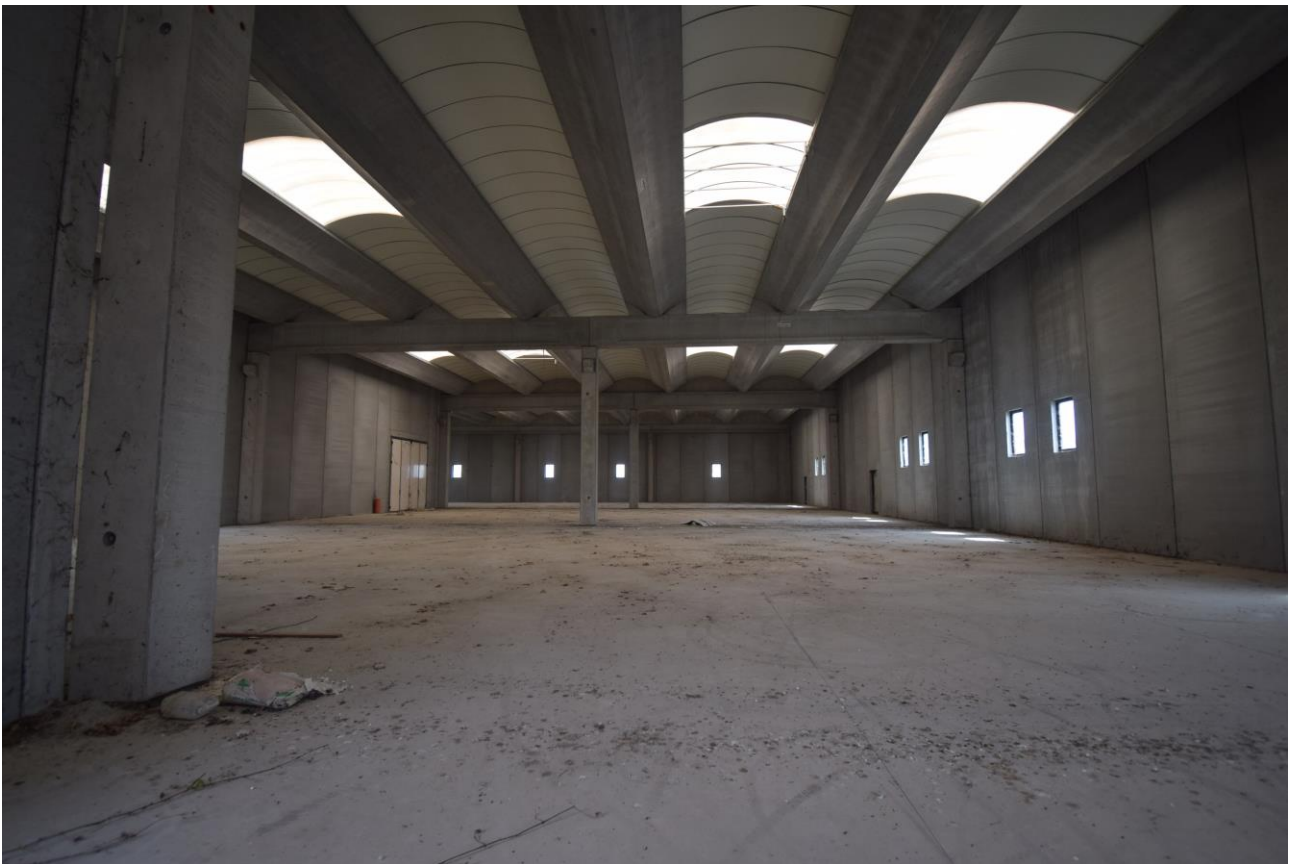
Fotografia n°12 Capannone B interno
