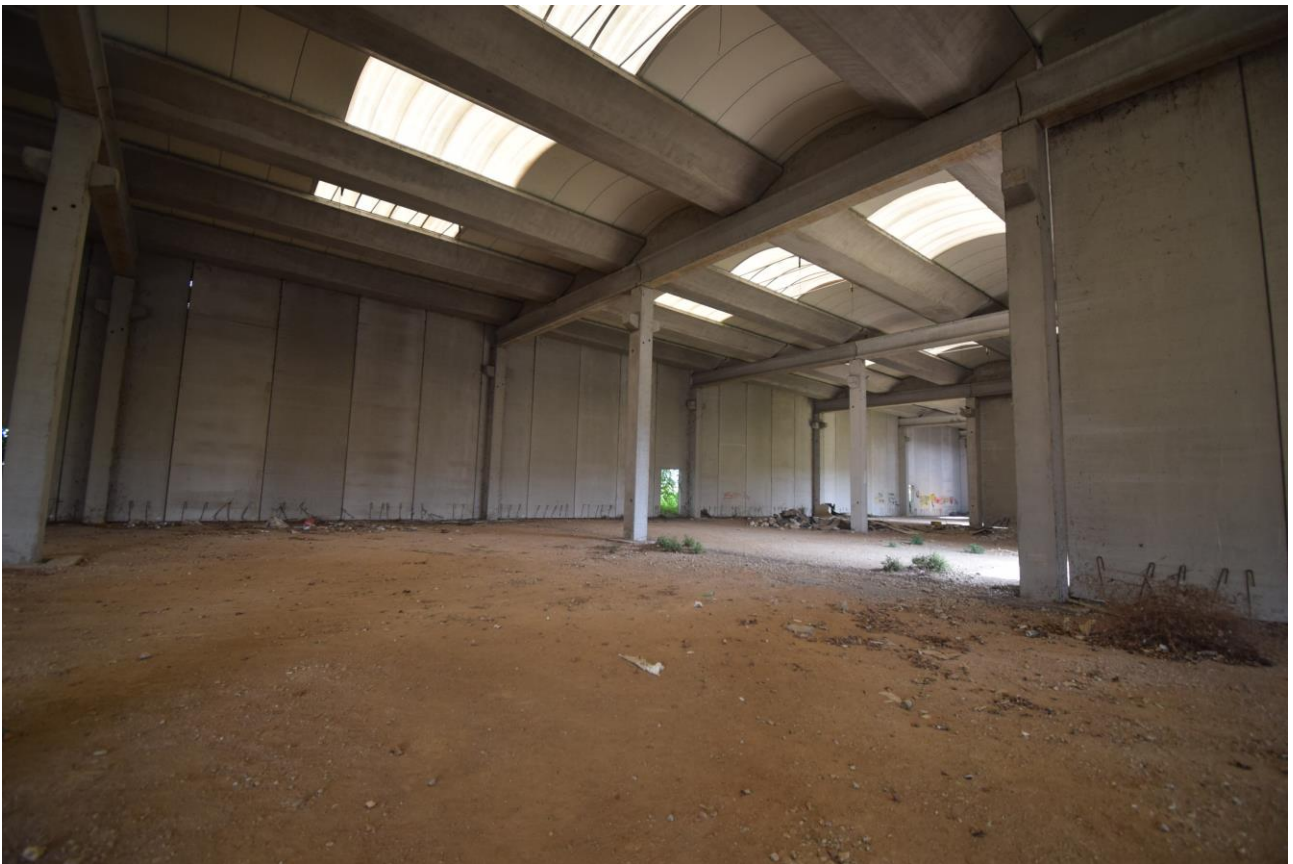
Fotografia n°6 Capannone A interno
