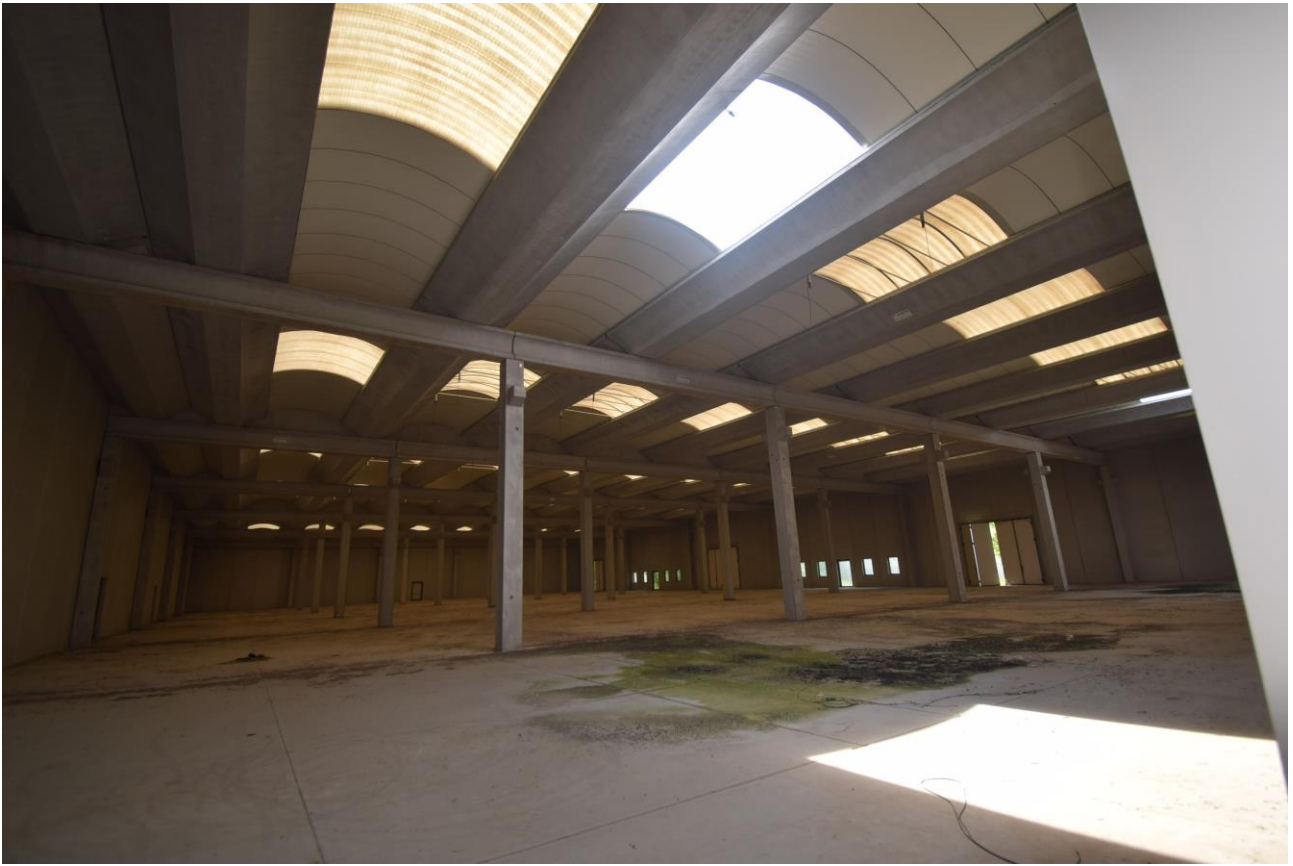
Fotografia n°15 Capannone C interno
