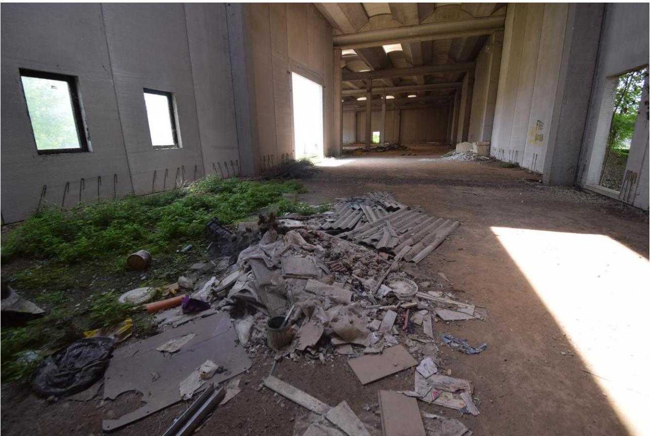
Fotografia n°8 Capannone A interno
