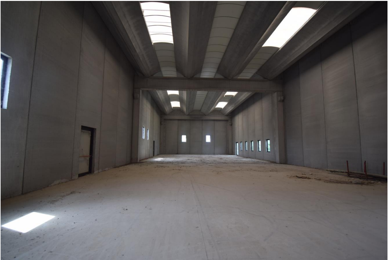
Fotografia n°13 Capannone B interno
