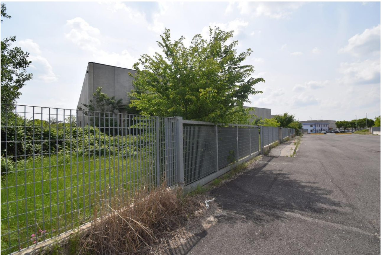
Fotografia n°10 Capannone B Esterno
