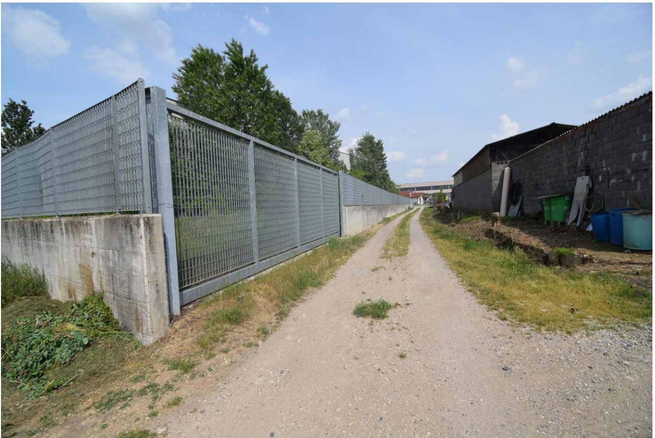
Fotografia n°18 Capannone C ingresso a sud
