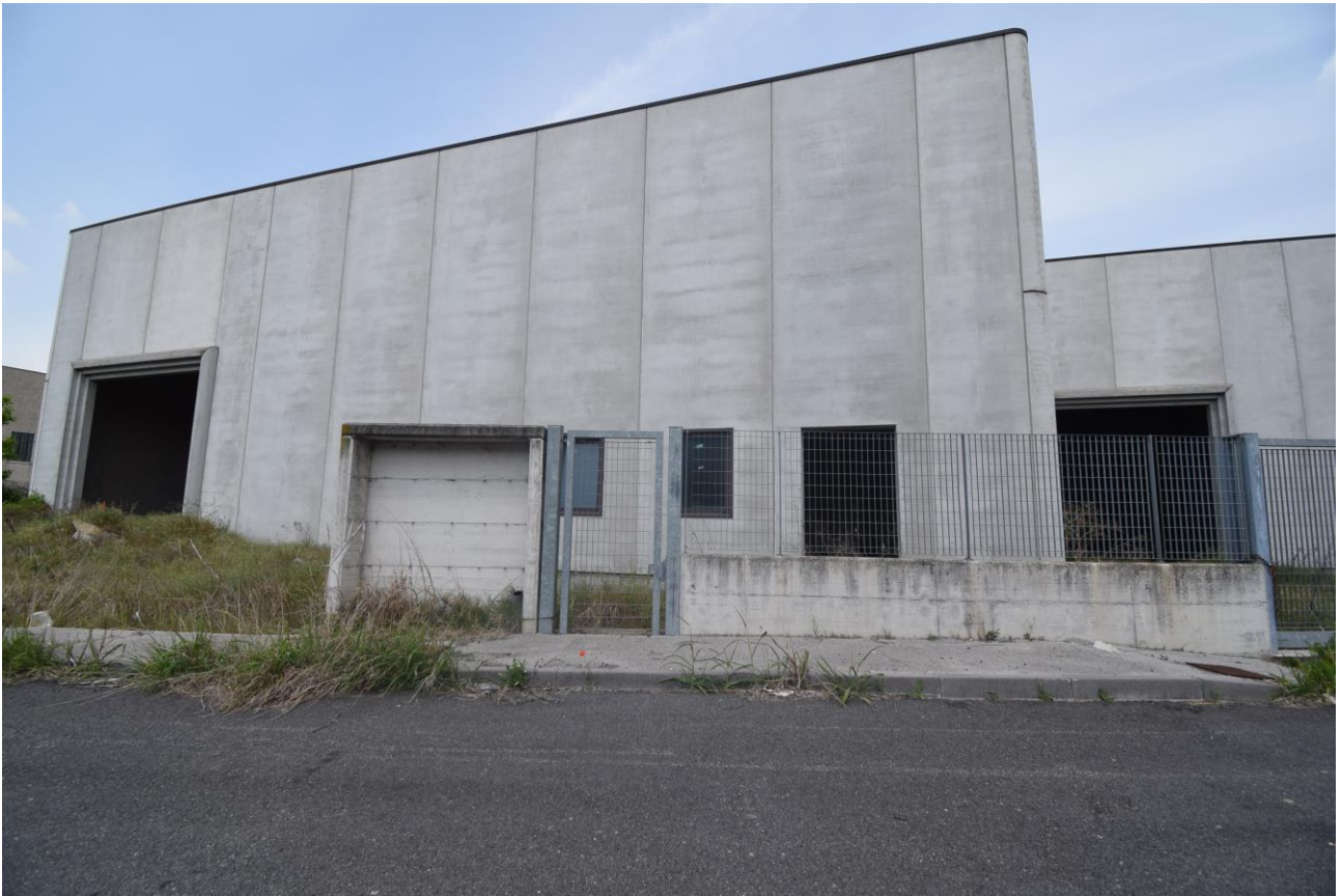
Fotografia n°5 Capannone A esterno
