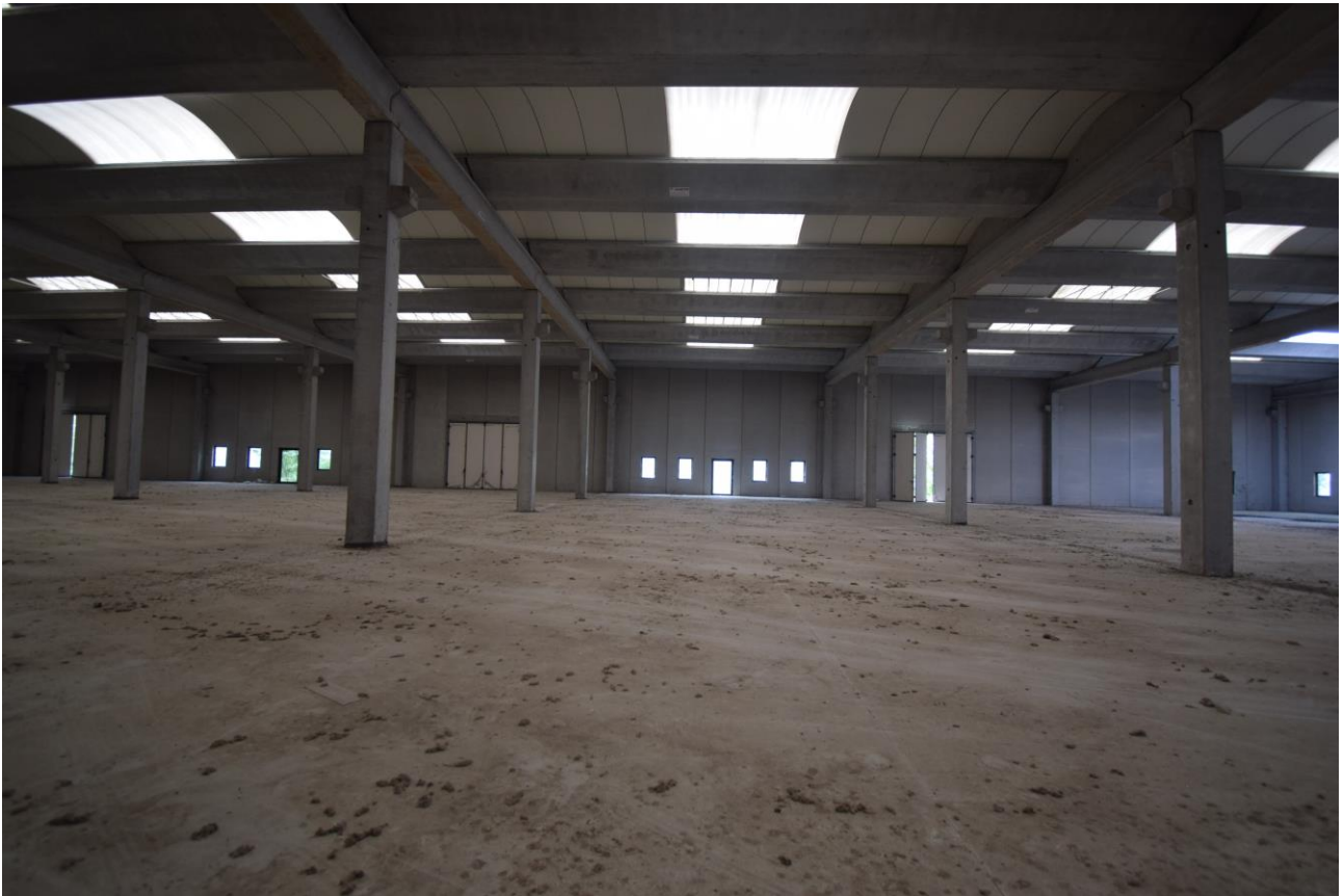
Fotografia n°16 Capannone C interno
