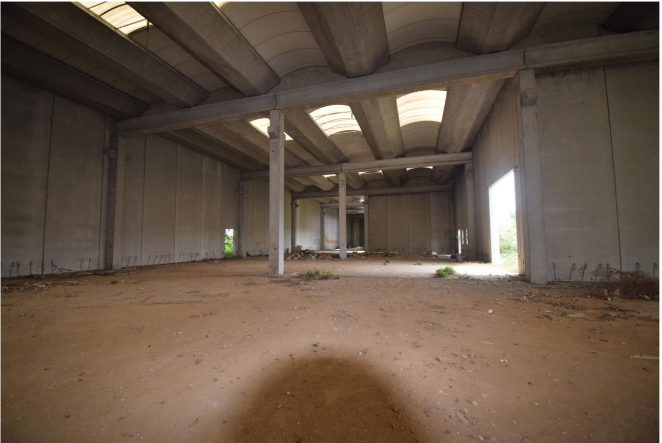
Fotografia n°7 Capannone A interno
