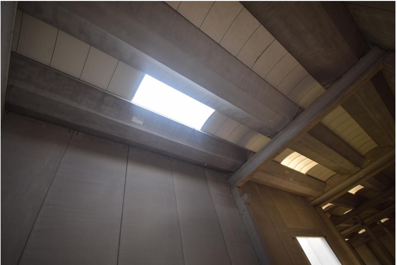
Fotografia n°9 Capannone A interno
