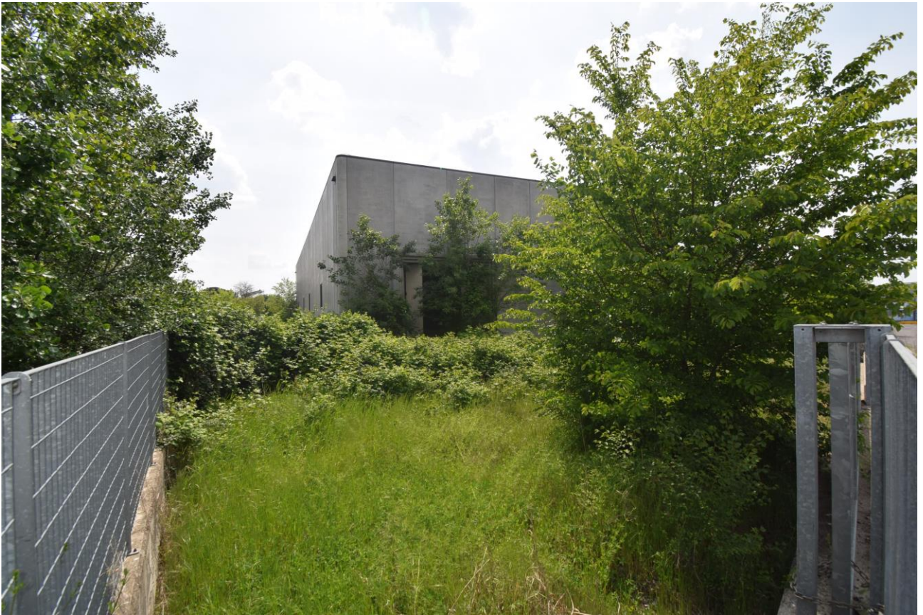
Fotografia n°11 Capannone B esterno
