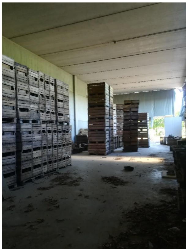
TETTOIA INTERNA A CAPANNONE
