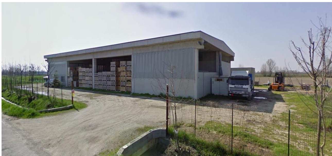
VISTA CAPANNONE DA VIA NAZARIO SAURO - ACCESSO
