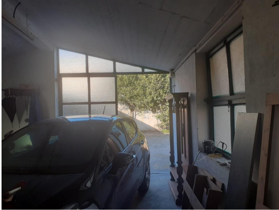
TETTOIA USATA COME AUTORIMESSA
