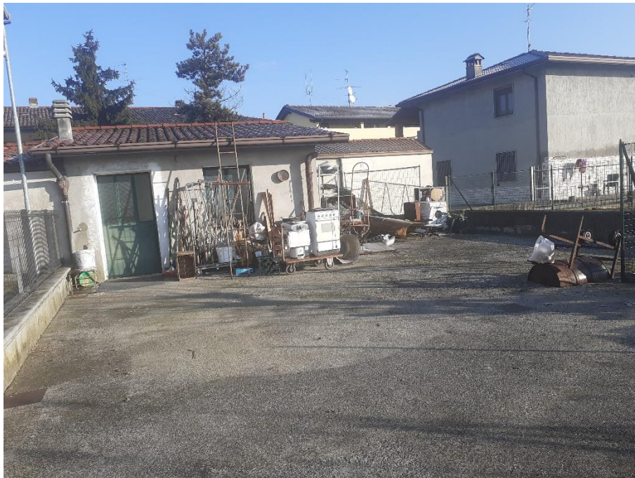
AREA URBANA VISTA VERSO FABBRICATI
