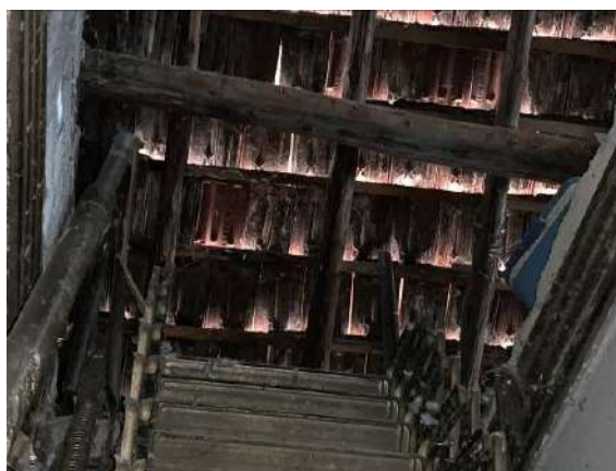
Figura 23: Vista del sottotetto
