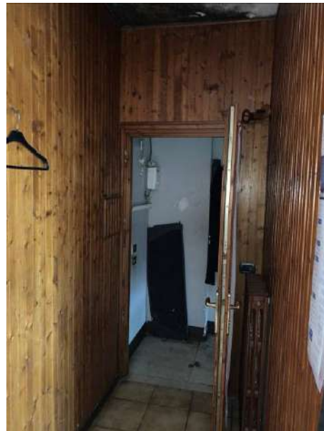
Figura 15: Vista dell'ingresso e del pianerottolo sbarco scala
