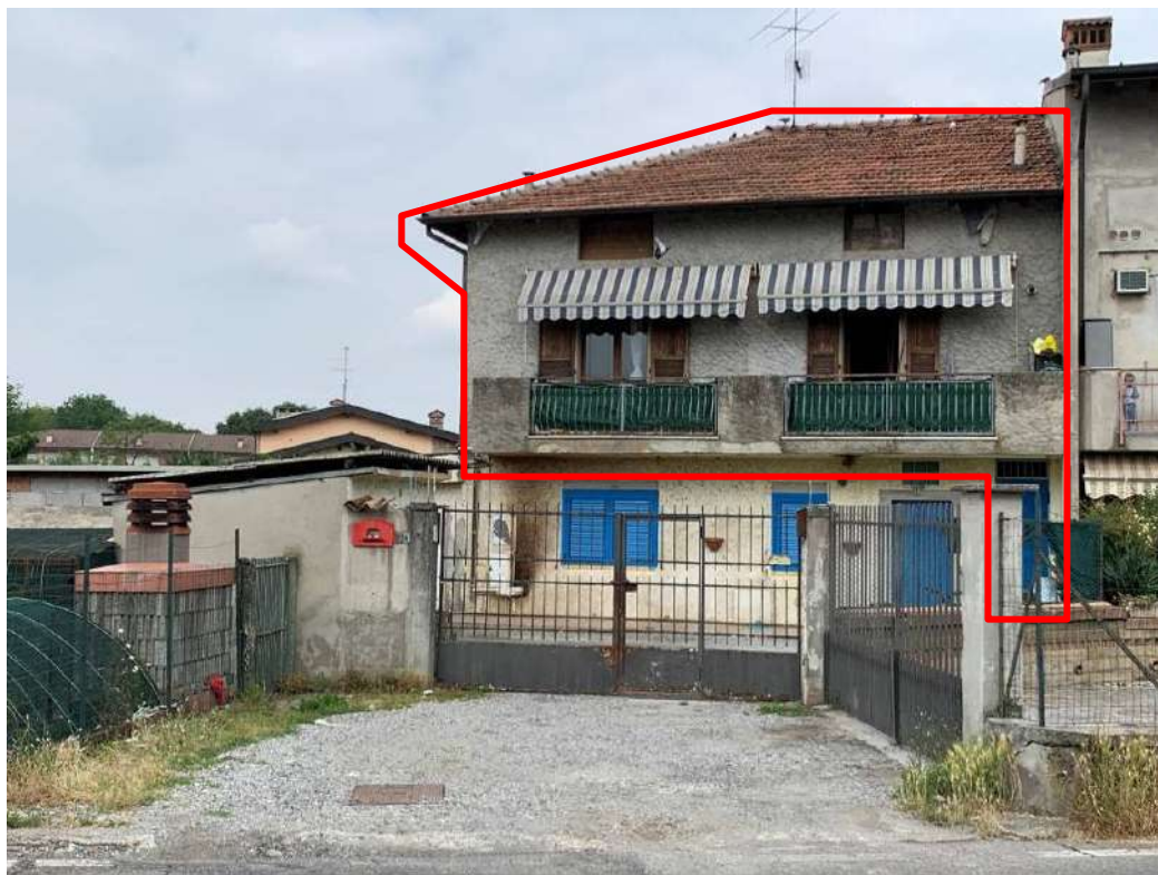
Fig. 04: Individuazione dell'immobile oggetto di perizia (prospetto Sud)
