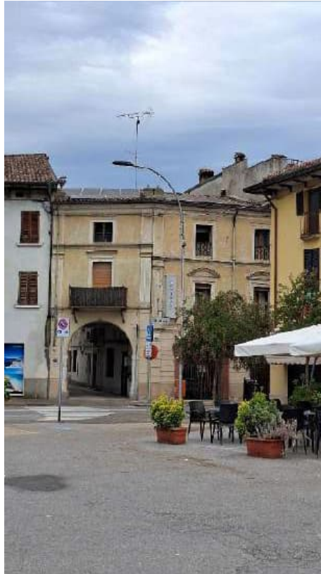
Foto n. 1 – prospetto su via XX Settembre, tetto con fotovoltaico
