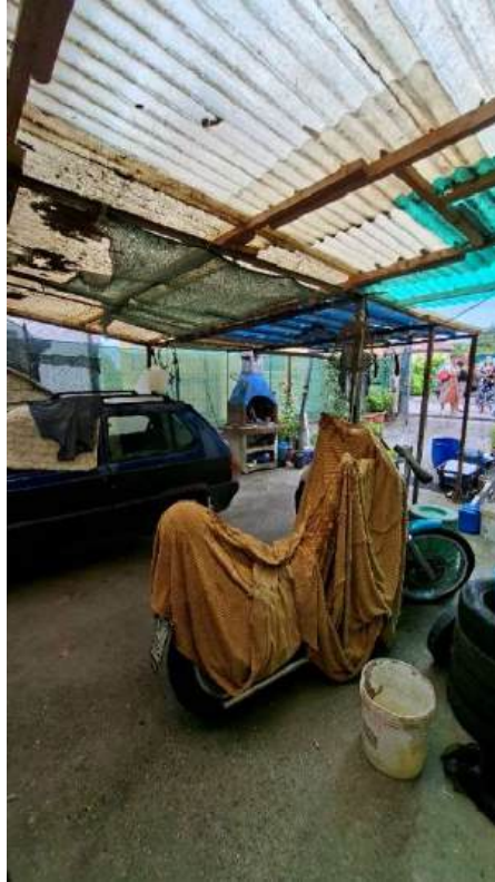
Foto n. 3 – tettoia in plexiglas
