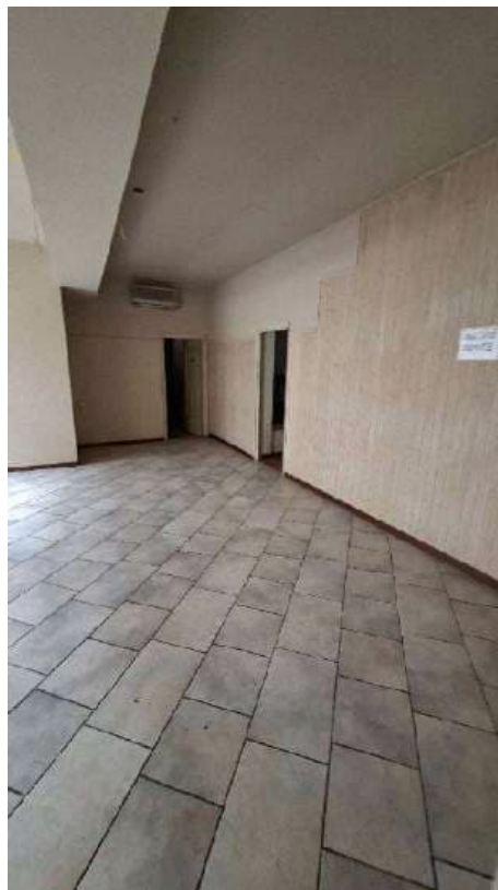
Foto n. 10 – salone lato sud
