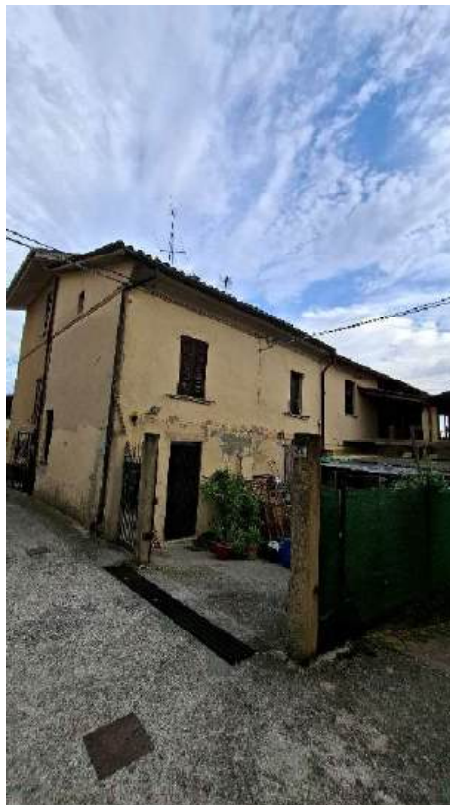
Foto n. 2 – prospetto da via Trento
