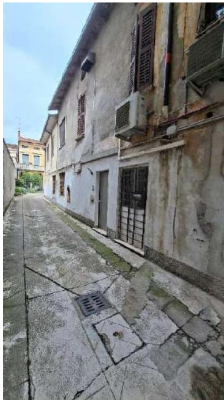
Foto n. 18 – passaggio comune lato verso via XX Settembre
