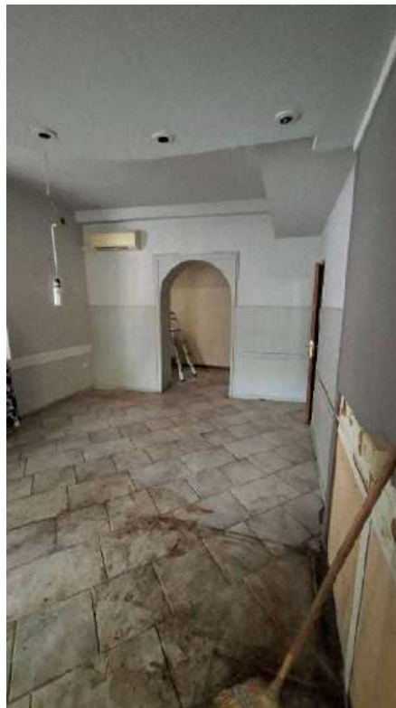
Foto n. 6 - salone del bar principale lato verso sud
