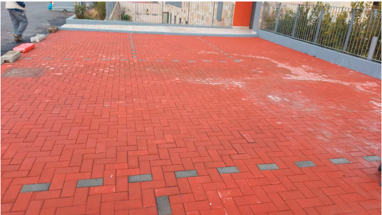
Area di posteggio esterna generale e particolare finitura a massetti
