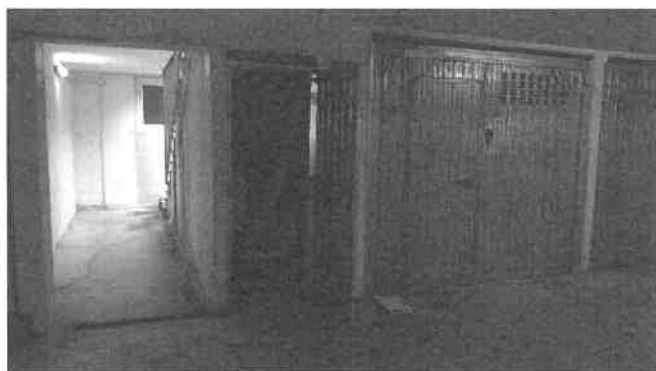
Figura 7 Sottoscala particella 2418 sub 46
