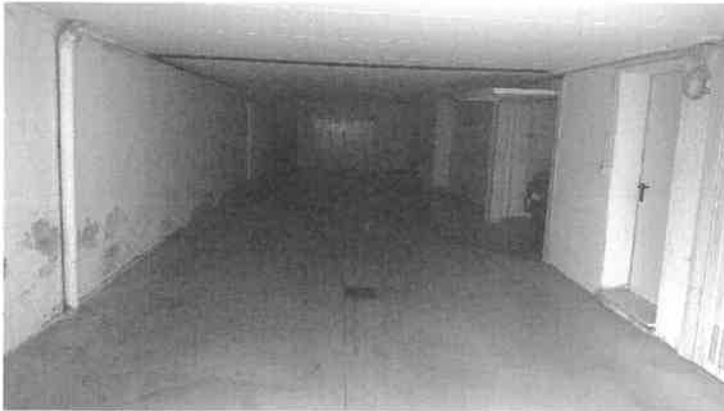
Figura 19 Vista interna sottoscala
