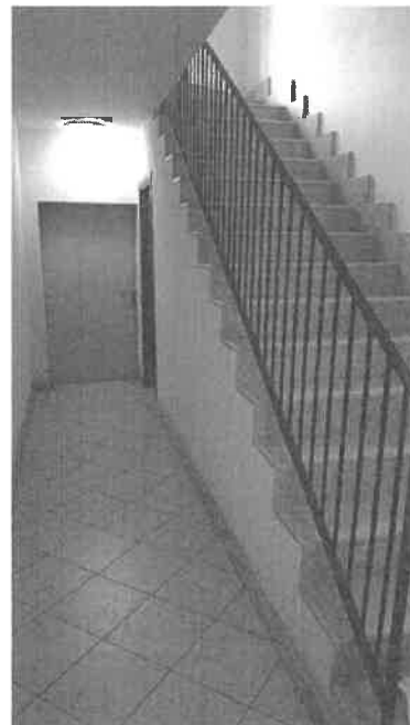
Figura 6 Sottoscala particella 2418 sub 45
