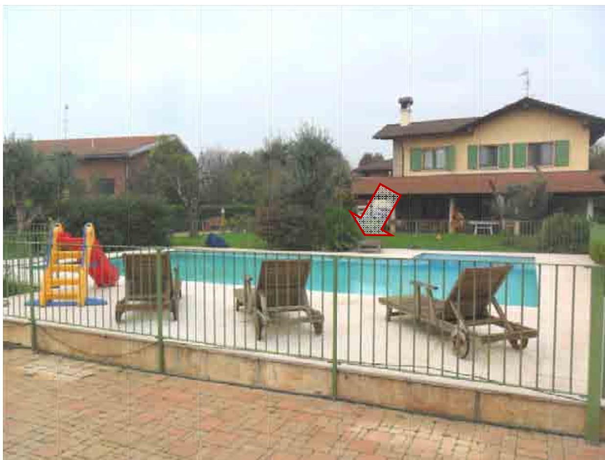
Elaborato fotografico della piscina non autorizzata e non accatastata
