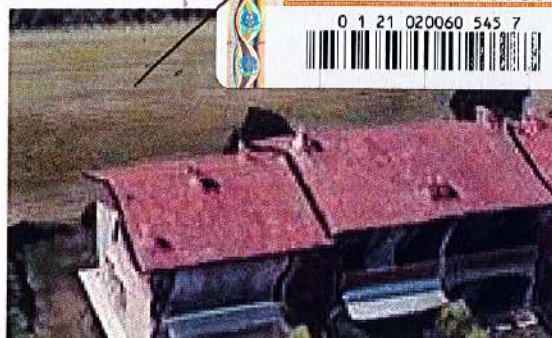
Figura 04: Vista dell'immobile in oggetto - fonte Google Maps
