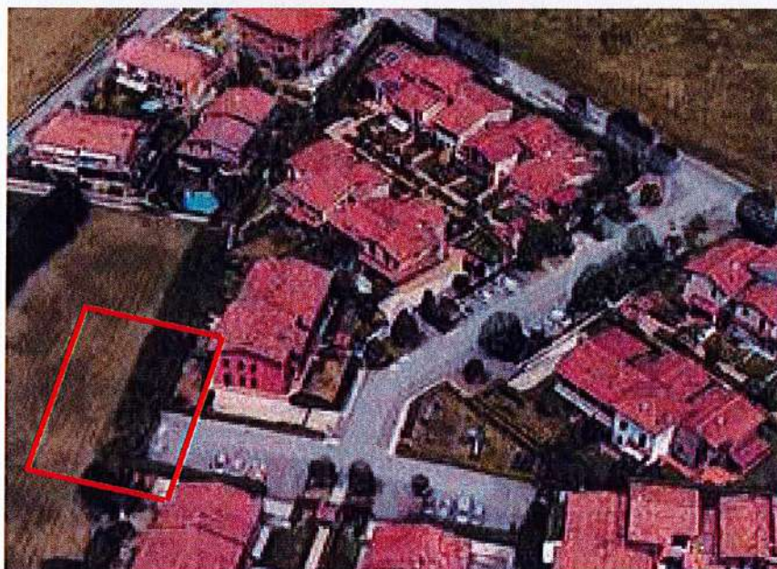
Figura 02: vista del complesso residenziale - Palazzina B - Lotto G - fonte google maps
