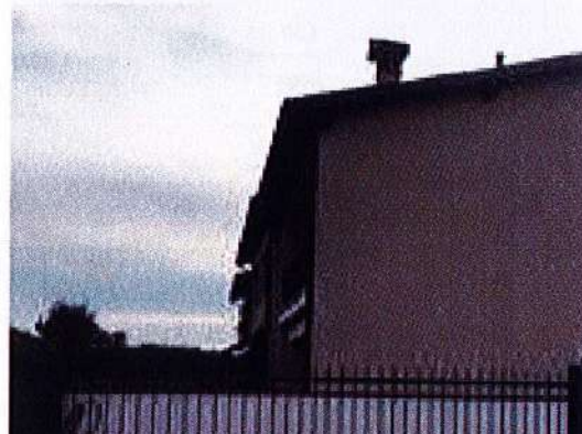
Figura 08: Ingresso carraio palazzina B civico 22b
