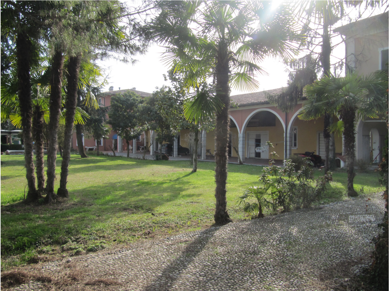
Immagine relativa al porticato pertinenziale della particella 545 sub.2
