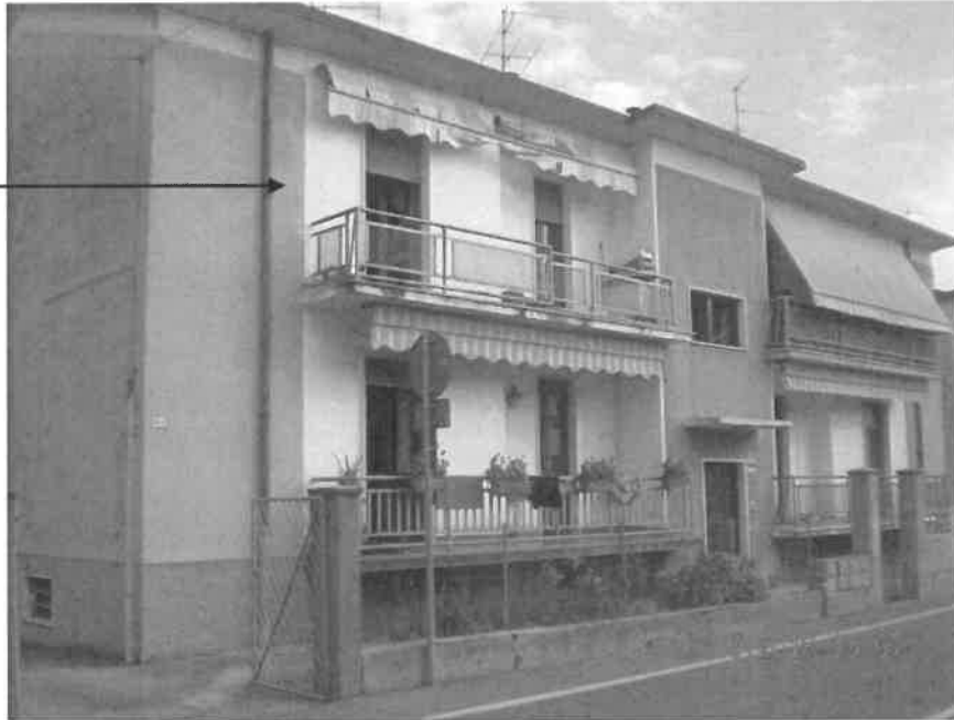
Figura 04: Visione esterna dell'immobile, fronte verso Via Monsignor G. Rizzi – fronte principale ovest, con indicazione dell'appartamento al 1° piano oggetto di perizia
