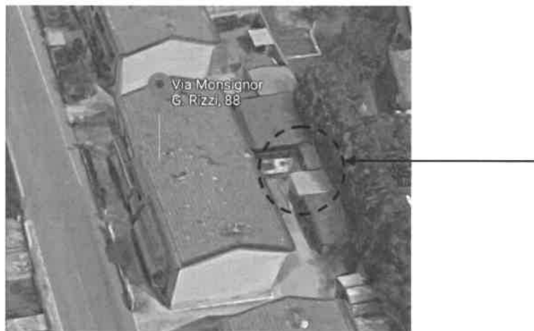
Figura 10: corte esclusiva con evidenziati ripostiglio e box – stato di fatto fonte google maps
