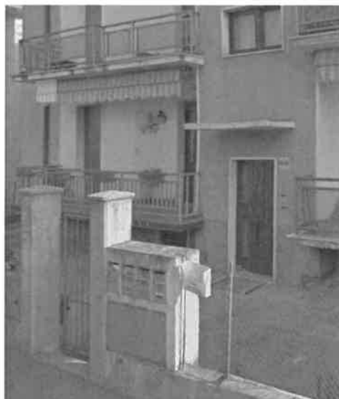
Figura 07: Particolare ingresso pedonale e portoncino d'ingresso
