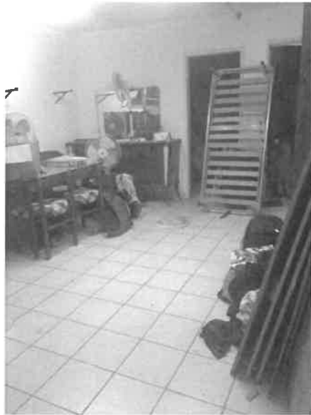
Figura 09: Interni della cantina – stato di fatto
