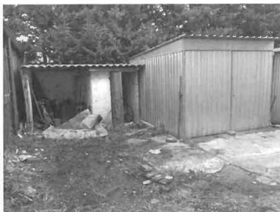
Figura 11: particolare ripostiglio e box – stato di fatto
