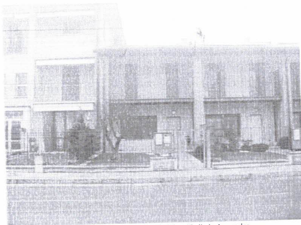
Immagine 3 prospetto sud, accesso pedonale al civico 13 di via Avogadro.
