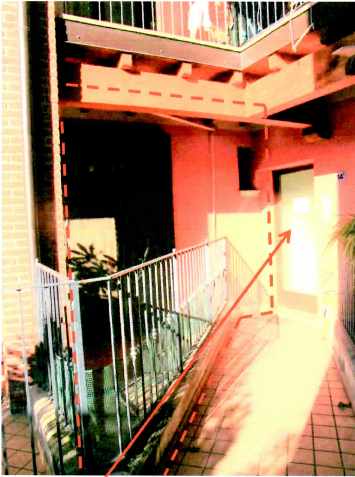
INGRESSO AL CONDOMINIO
