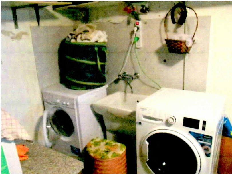
Interno del garage con angolo dotato di attacco e scarico per lavatoio e lavatrice
