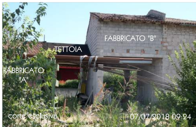
Foto 4: Tettoia tra i Fabbricati "A" e "B"
