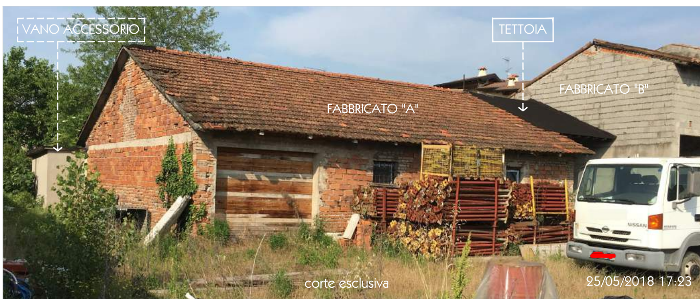
Foto 5: Vista Sud/Ovest del Fabbricato "A" con il Vano Accessorio ad esso addossato e della Tettoia
