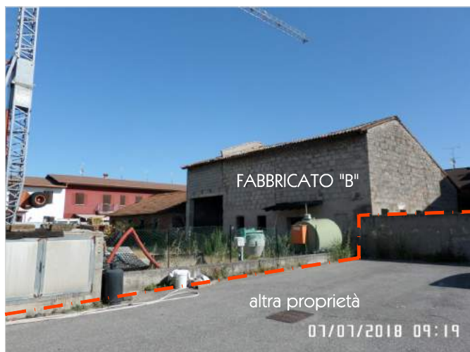
Foto 14: Recinzione lato Est e Fabbricato "B"
