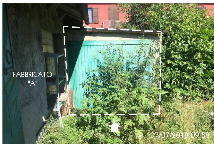
Foto 11: Vano Accessorio > fronte Est
