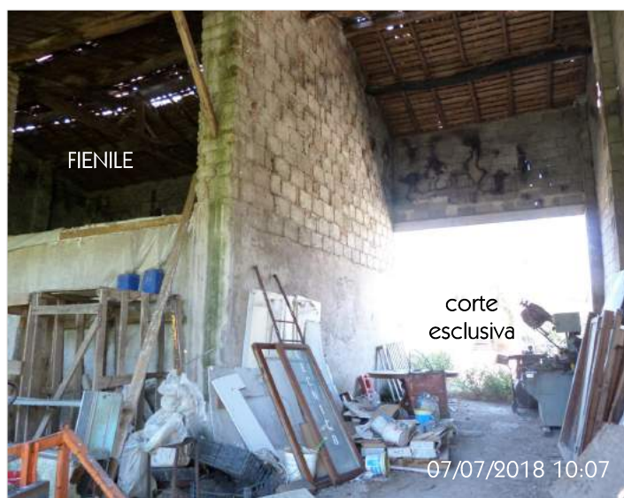
Foto 21: Fabbricato "B" > Vista del Portico lato Sud
