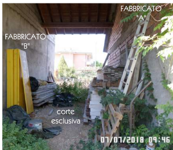
Foto 10: Tettoia > vista Nord-Sud
