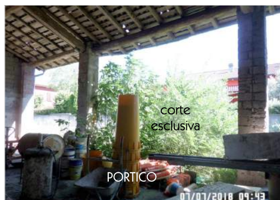
Foto 16: Fabbricato "B" > Portico lato Nord
