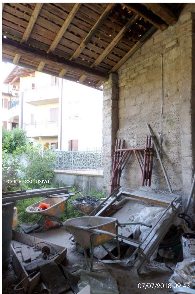
Foto 17: Fabbricato "B" > Portico e recinzione lato Est
