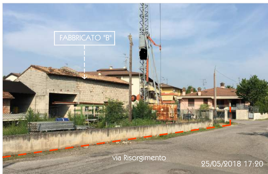
Foto 7: Recinzione lato Sud su via Risorgimento
