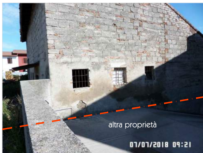
Foto 15: Recinzione lato Est e Fabbricato "B"
