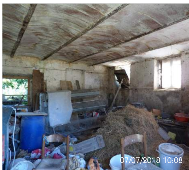
Foto 20: Fabbricato "B" > Vista del Magazzino
