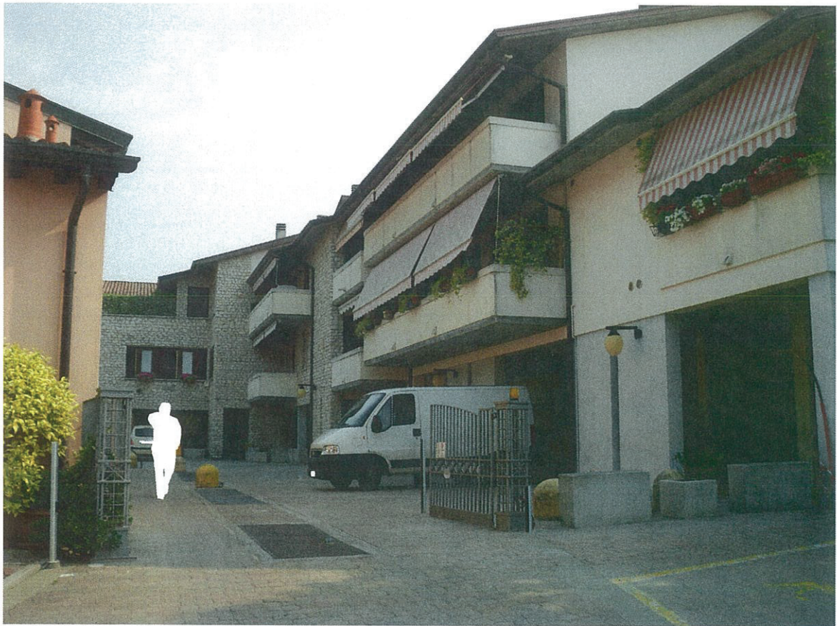
Vista ingresso carraio e pedonale al condominio “La Galleria”
