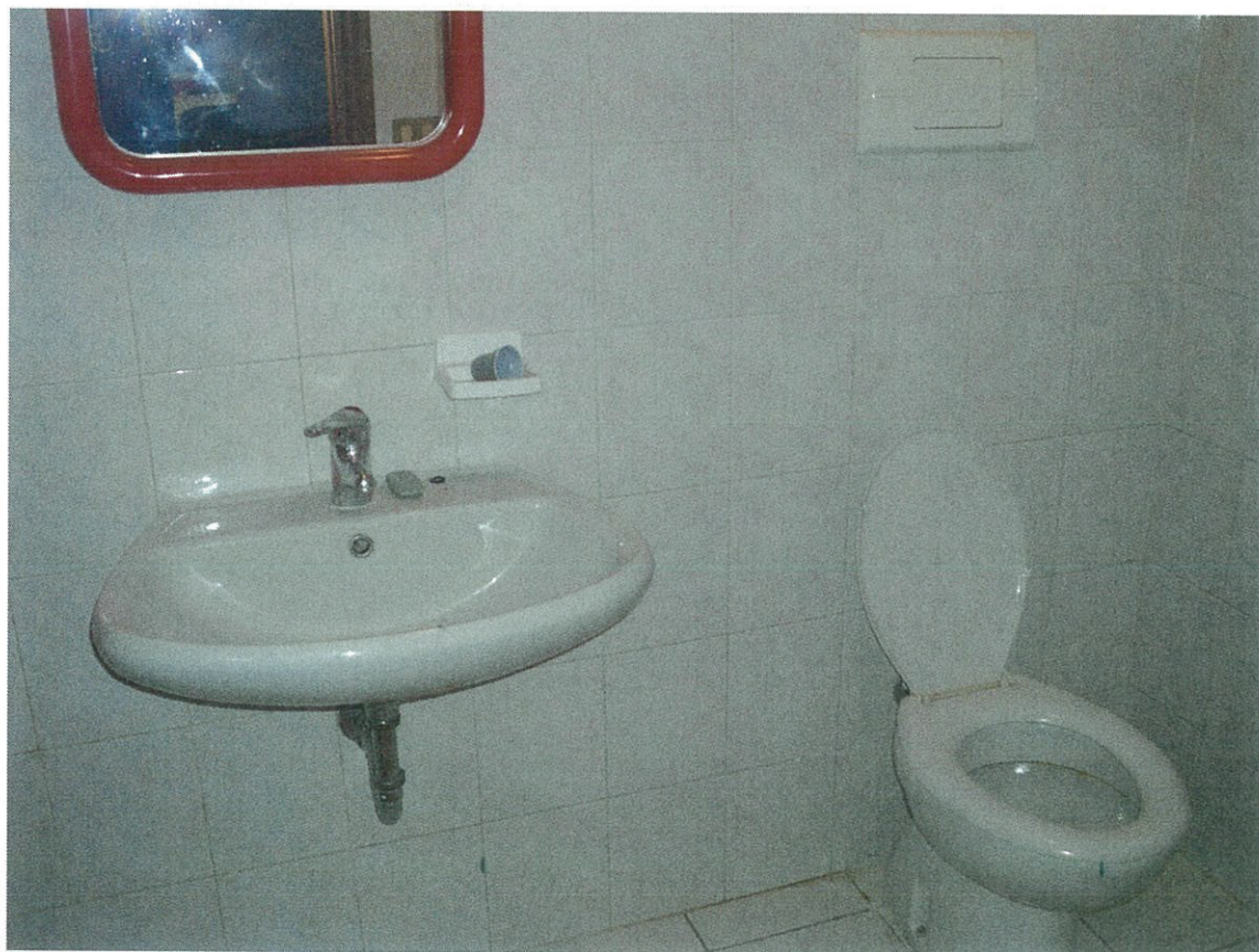
Vista del bagno nel piano interrato
