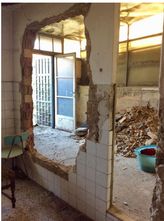
Particolare della parete della cucina sulla veranda. Si possono vedere la porta a destra priva di serramento e la parete praticamente demolita sulla veranda.
