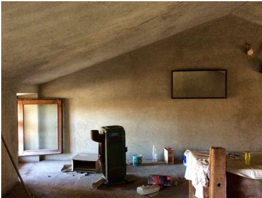
Ulteriore particolare del sottotetto. E' visibile il pavimento in battuto di cemento.
