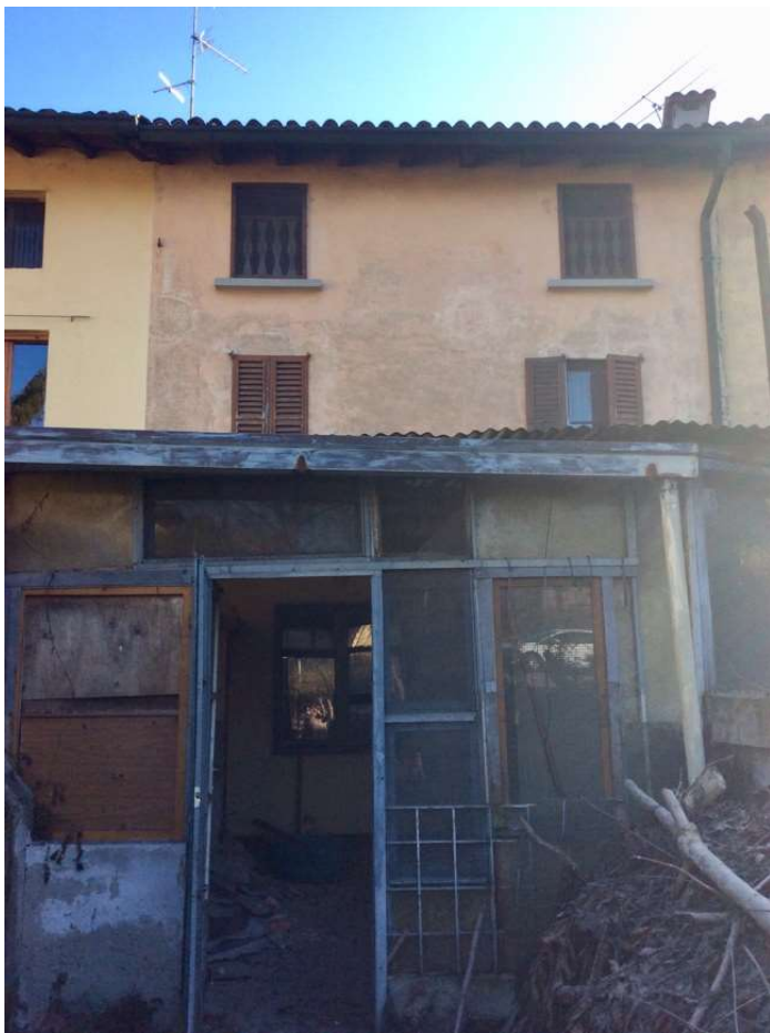
Particolare della veranda che ne evidenzia il cattivo stato della struttura e della chiusura.
