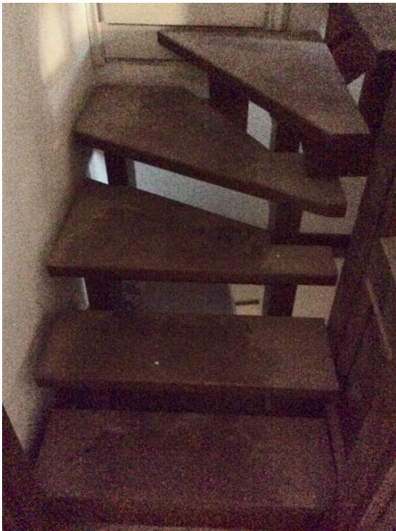
Particolare dei gradini di arrivo al sottotetto della scala della foto precedente.
