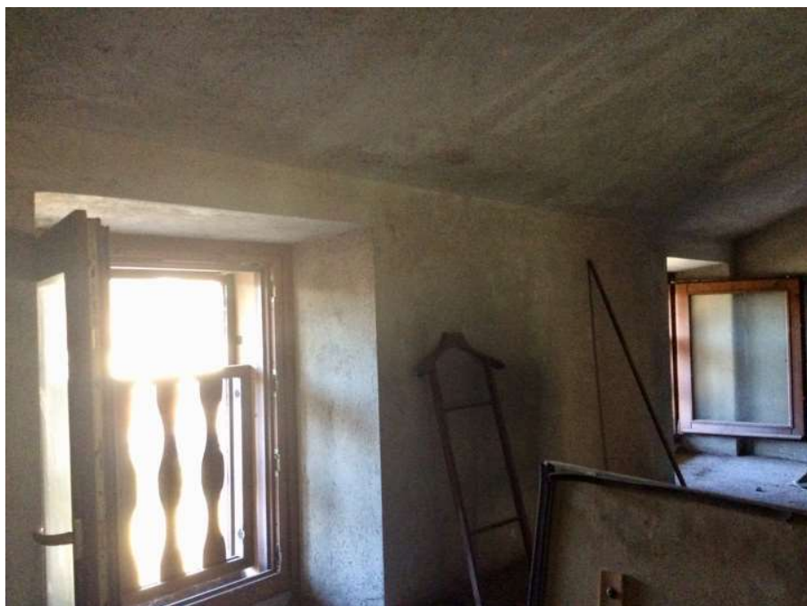
Particolare del sottotetto sopra il balcone. Sono visibili la porta-finestra chiusa con ringhiera in legno sopra il solaio del bagno e la finestra in corrispondenza della porta della camera da letto sul balcone.
