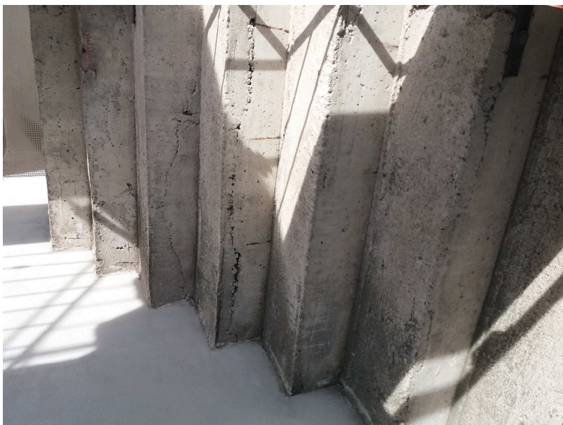
Vista scala accesso comune mappale 742 sub 502 ;mappale 743 sub 2
