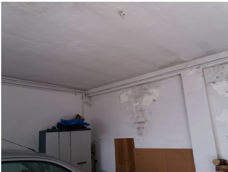
Vista autorimessa mappale 2367 sub 2
