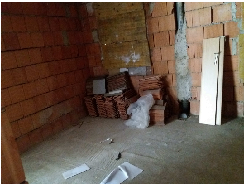
Vista interno mappale 742 sub 502 piano primo
