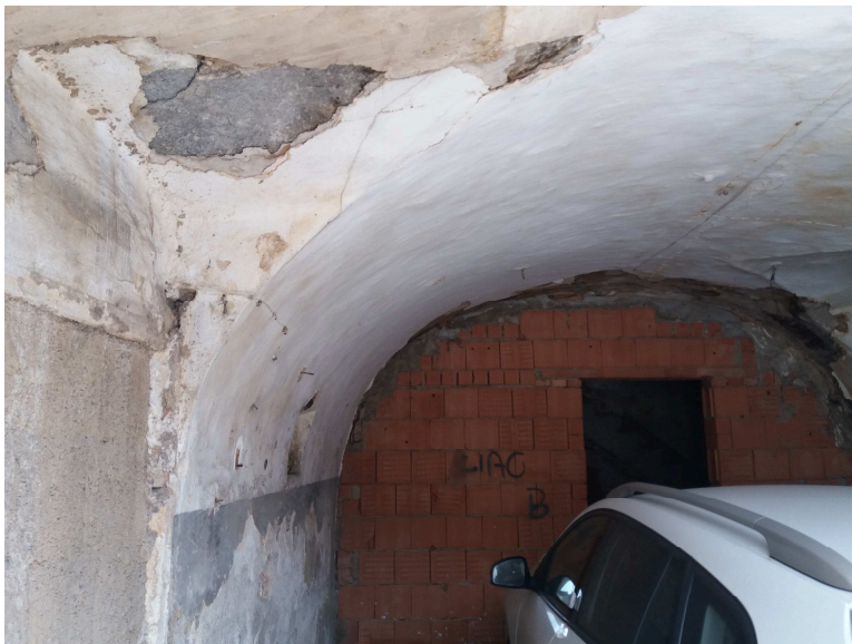
Vista immobile interno mappale 742 sub 502 piano terra
