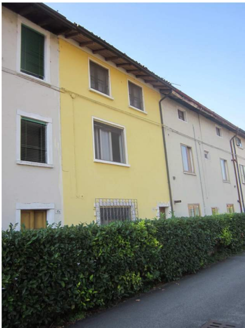
Foto 13: vista del fabbricato dal fronte nord (fabbricato colore giallo)
