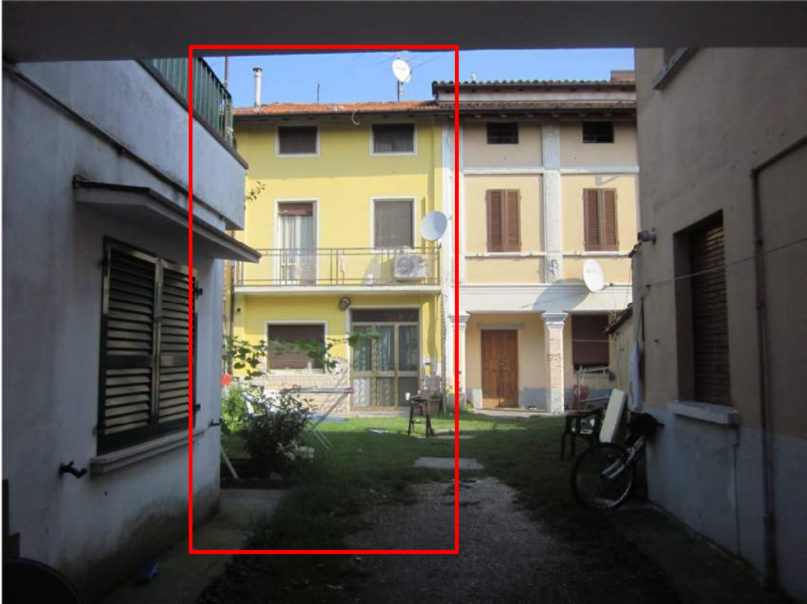
Foto 2: cortile e fabbricato visti dal portone di via Tito Speri n. 107
