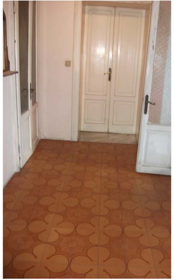
scala comune - pianerottolo P. T
