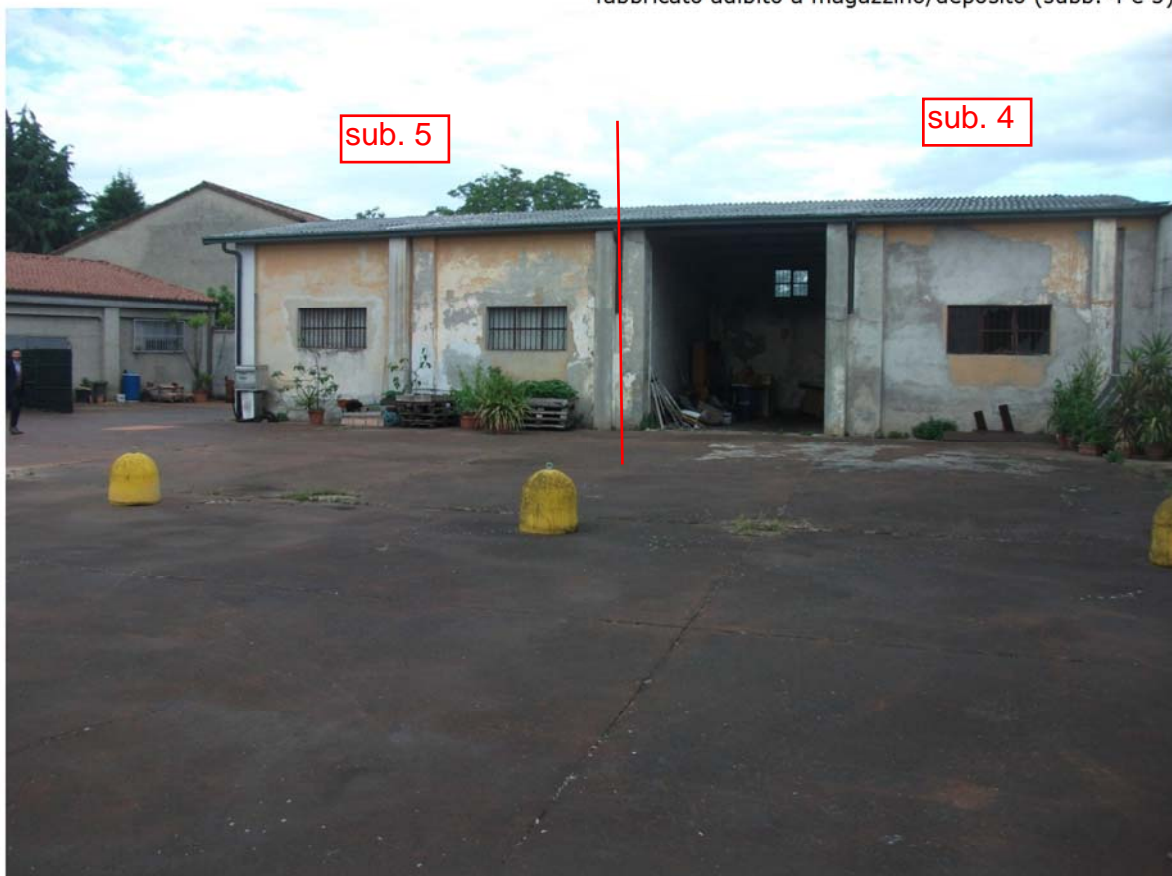
fabbricato adibito a magazzino/deposito (subb. 4 e 5)
