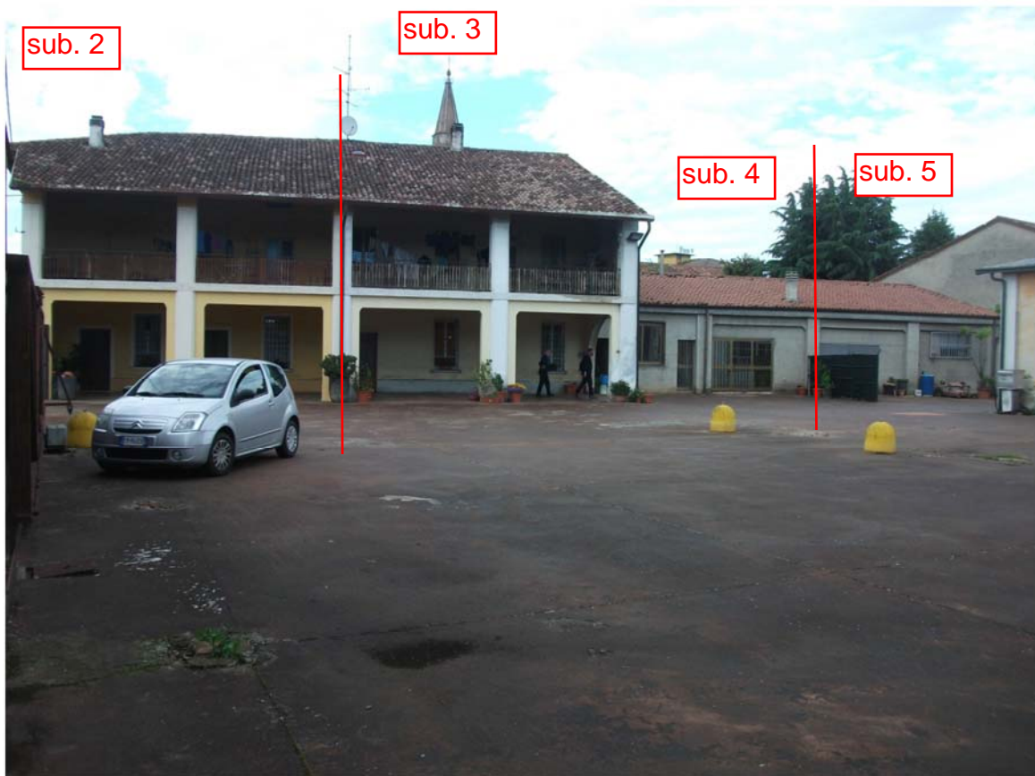
fabbricato adibito ad abitazione (subb. 2 e 3) e fabbricato accessorio (subb. 4 e 5)
