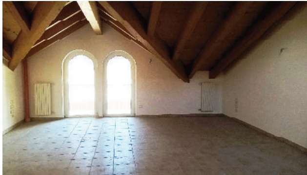
FOTO N. 26 : interno unità sub. 49 (soffitta piano sottotetto)
