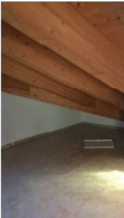
FOTO N. 51: interno unità sub. 55(soffitta piano sottotetto)
