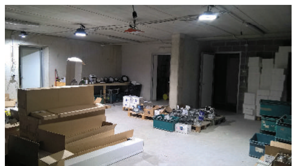
FOTO N. 60 : interno unità sub. 28 piano interrato
