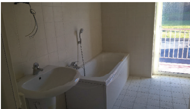
FOTO N. 23: interno unità sub. 67 (bagno)
