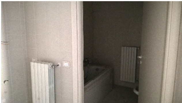
FOTO N. 25: interno unità sub. 49 (piano primo)
