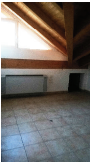
FOTO N. 53: interno unità sub. 56 (soffitta piano sottotetto)
