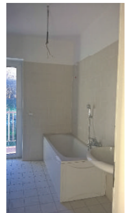
FOTO N. 44: interno unità sub. 68
