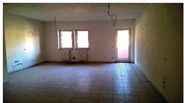
FOTO N. 24 : interno unità sub. 49 (piano primo)
