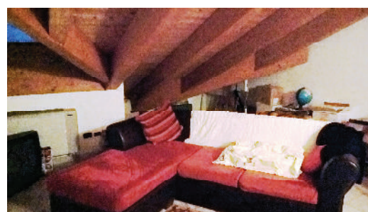
FOTO N. 36 : interno unità sub. 51 (soffitta piano sottotetto)
