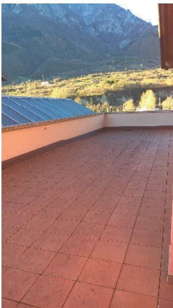
FOTO N. 31: terrazzo unità sub. 50
