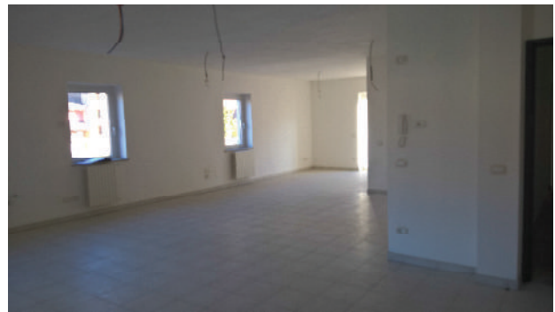
FOTO N. 22 : interno unità sub. 67
