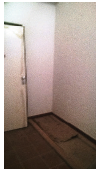
FOTO N. 48 : interno unità sub. 55 (accesso piano primo)
