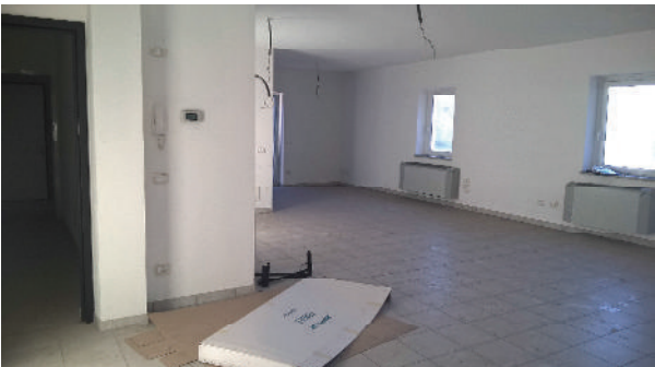
FOTO N. 43: interno unità sub. 68
