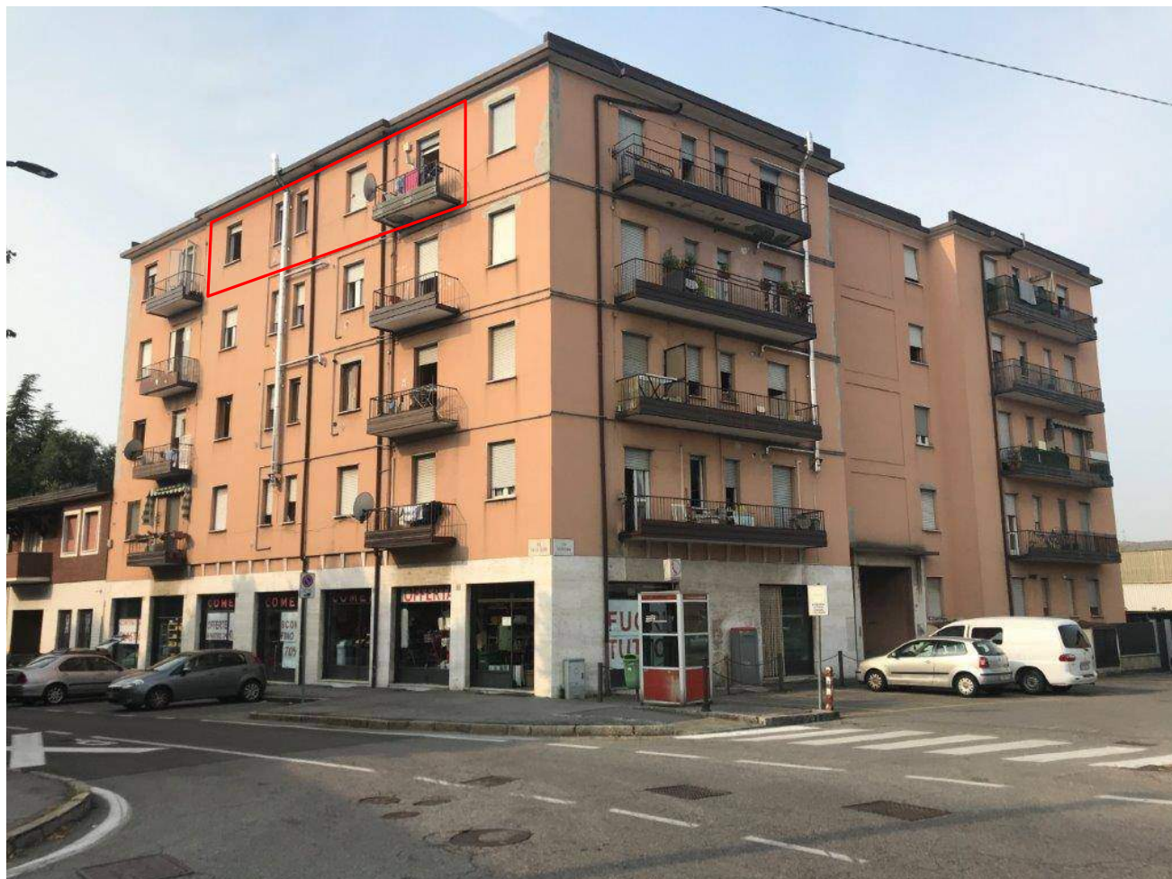
Fig. 03 – Incrocio tra Via Morosini e Via Villa Glori - Indicazione dell'immobile oggetto di perizia - Fonte Google Maps
