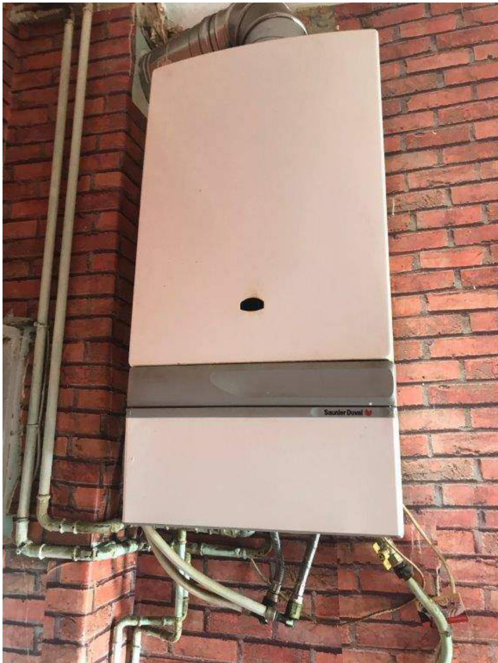
Fig. 21 – Impianti: caldaia
