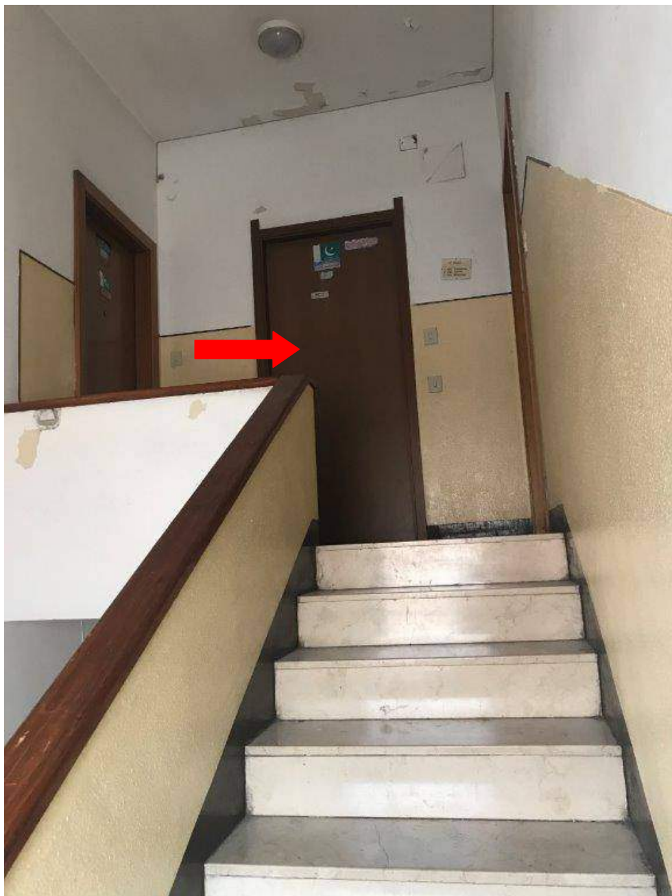
Fig. 07 – Vano scala comune – accesso all'appartamento
