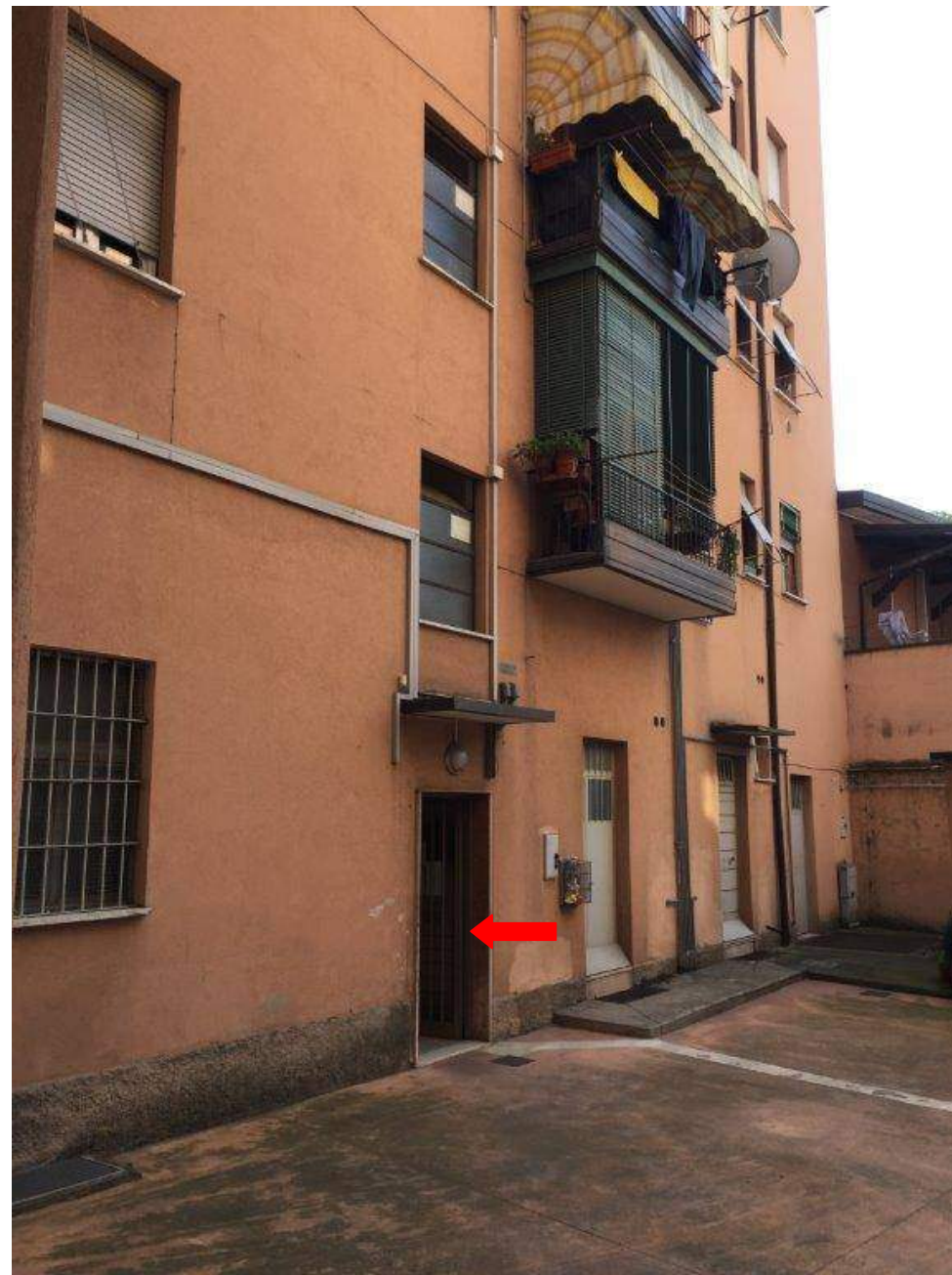
Fig. 06 – Accesso al vano scale condominiale
