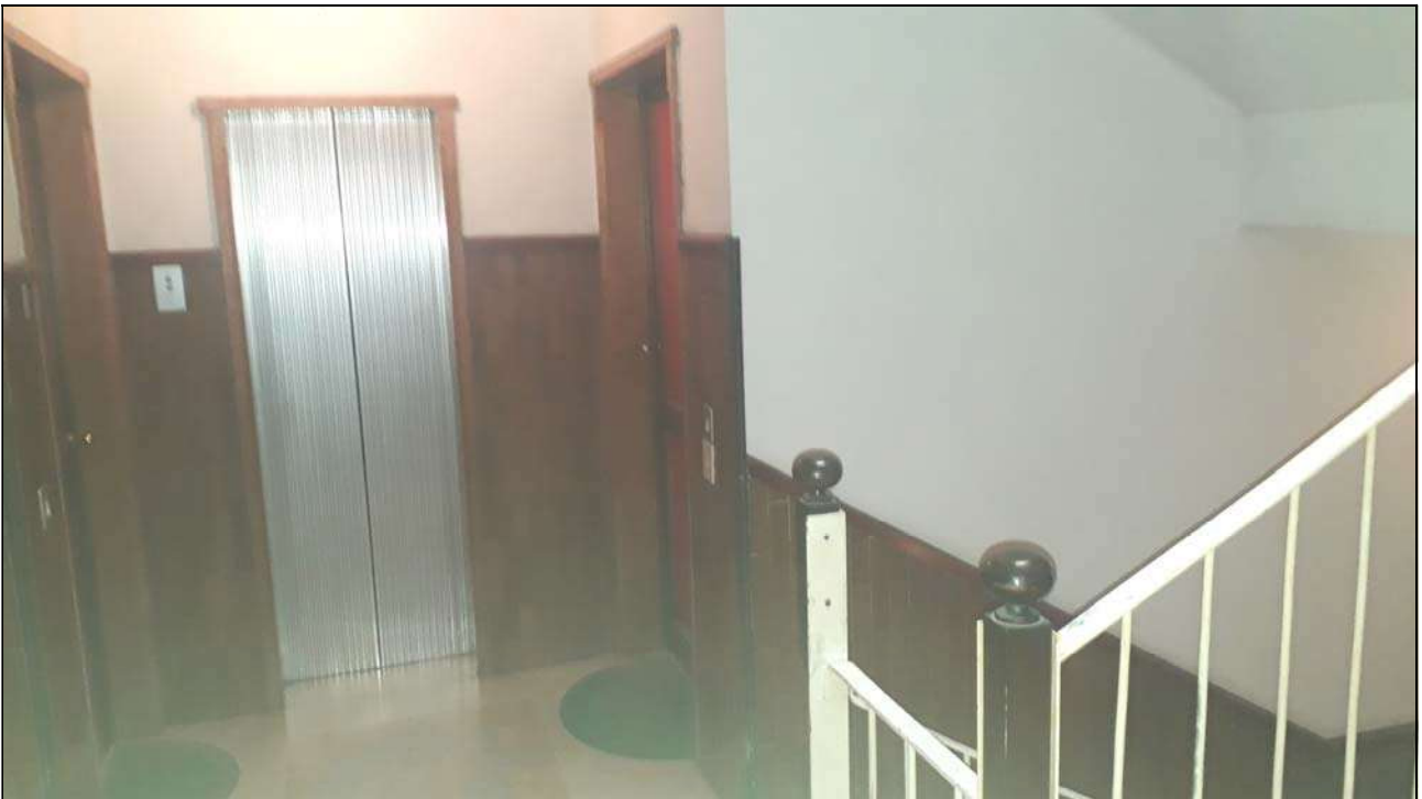
Foto n. 2 – pianerottolo e ascensore
