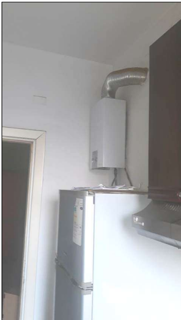
Foto n. 18 – zona cottura e caldaietta acqua Sanitaria
