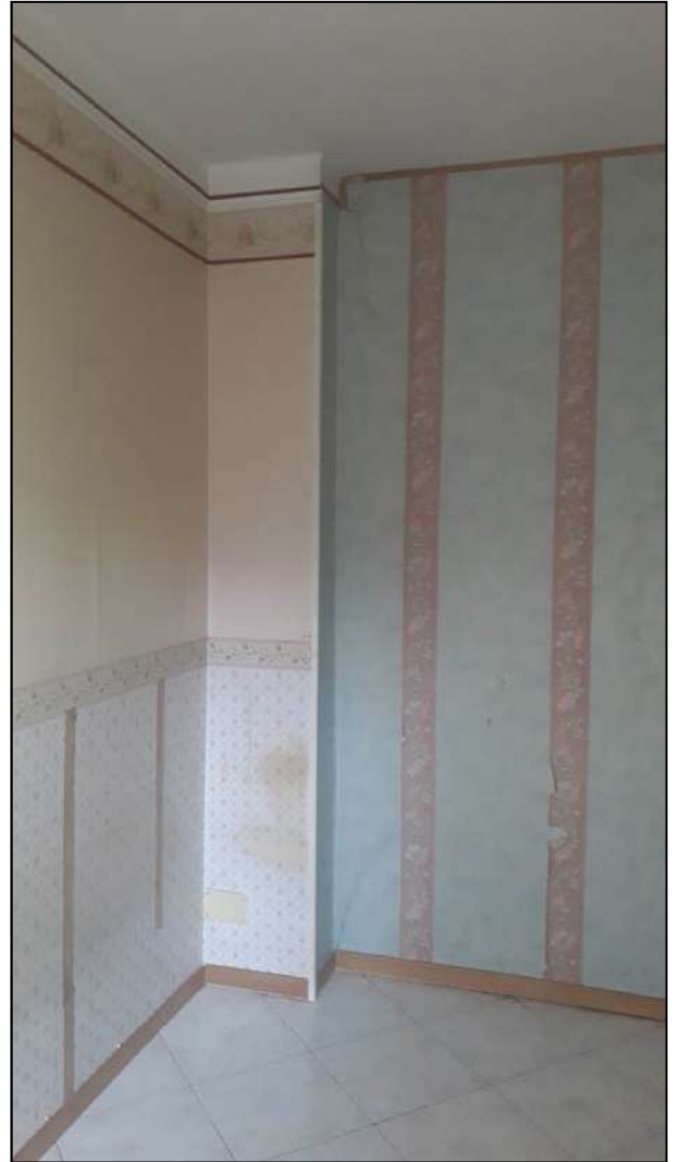
Foto n. 13 – sala da pranzo
