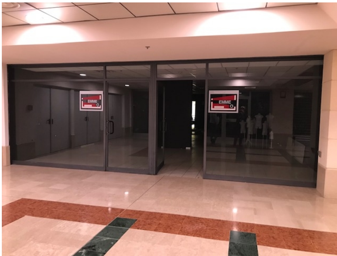
1 ingresso da galleria del centro commerciale
