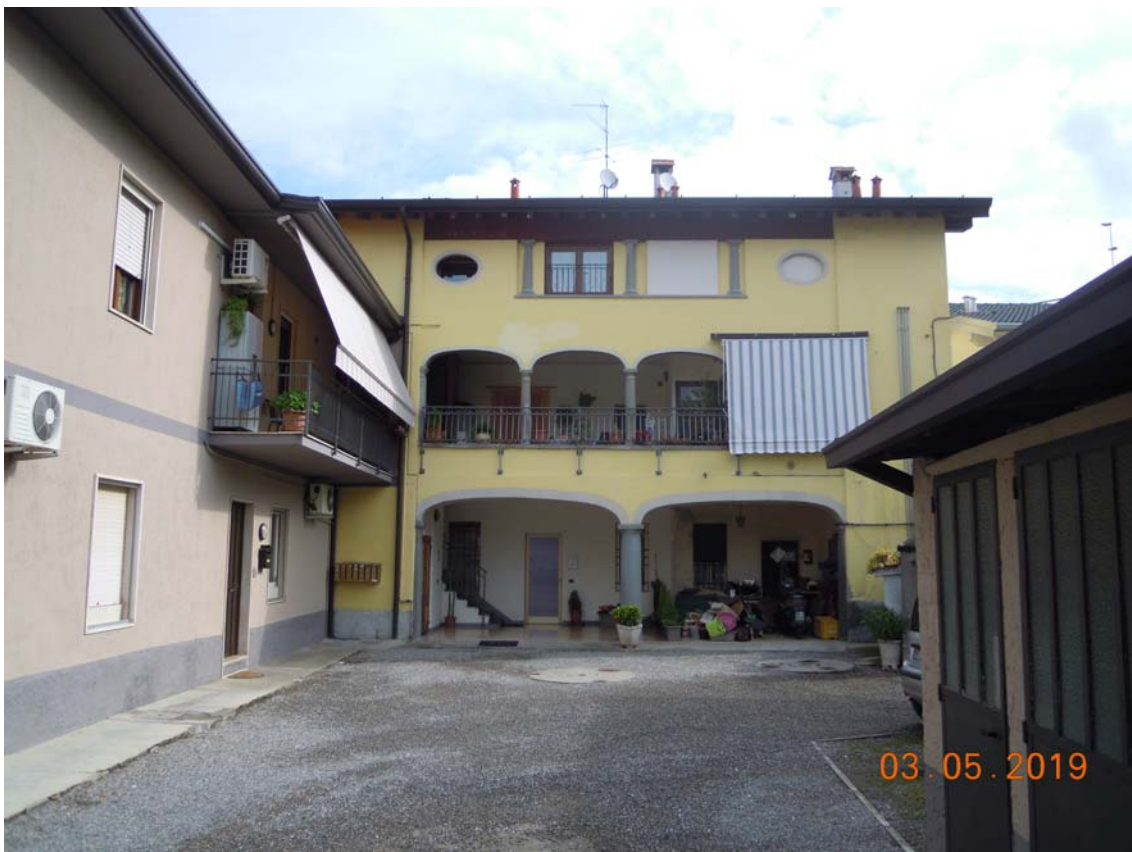
Foto 4 – Facciata sud su corte comune
