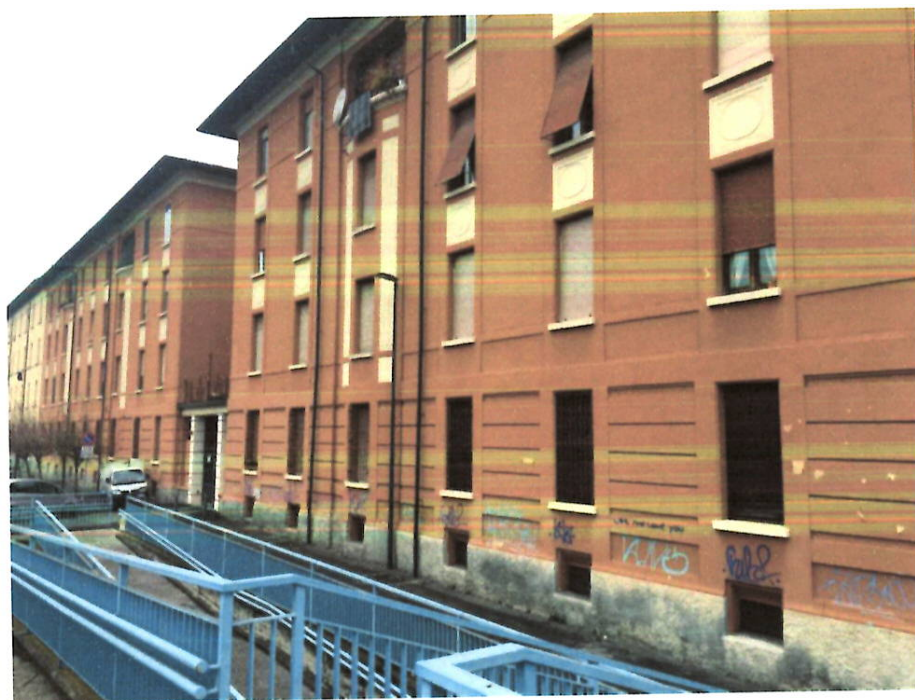
22 – vista del condominio sul via Verona
