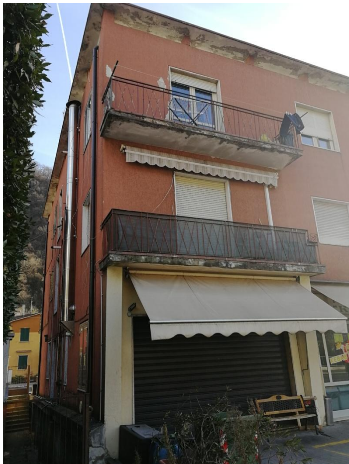
Foto 2: Dettaglio affaccio balcone fronte ovest
