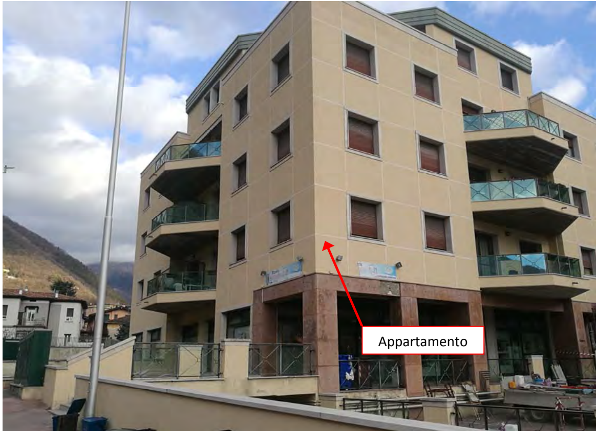
Foto 7: Vista esterna, spigolo sud-ovest della torre "C"
