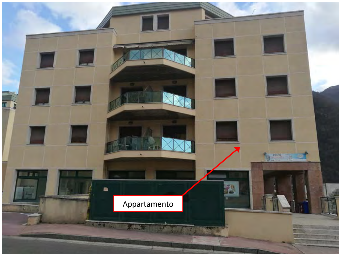
Foto 8: Vista esterna, facciata ovest della torre "C"
