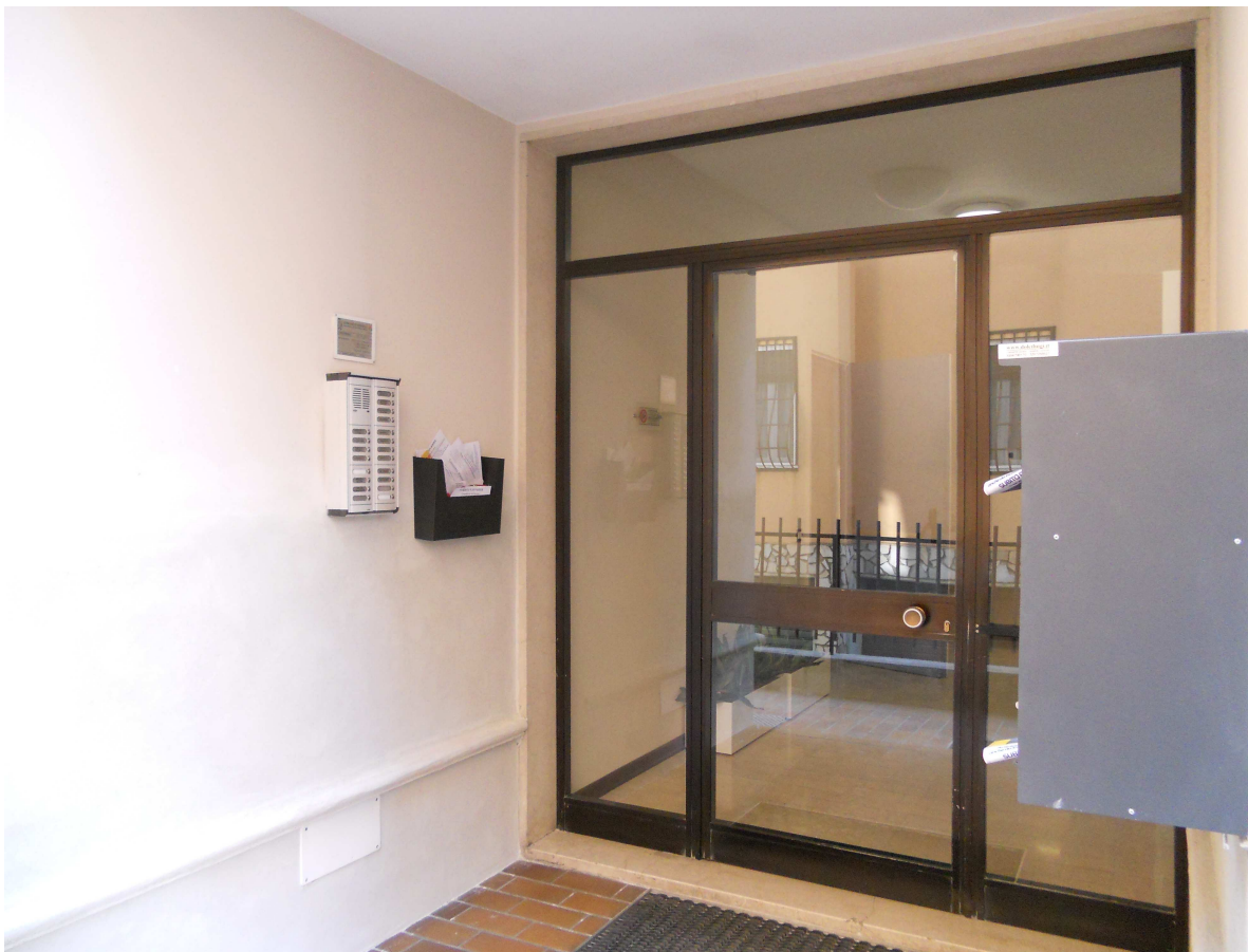
1) Fotografia riprendente l'ingresso pedonale al condominio.
