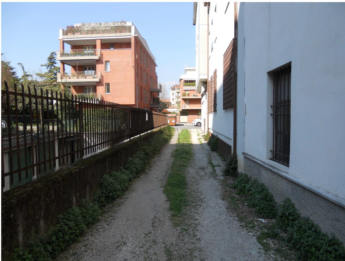
2) Fotografia riprendente l'ingresso carraio al condominio.
