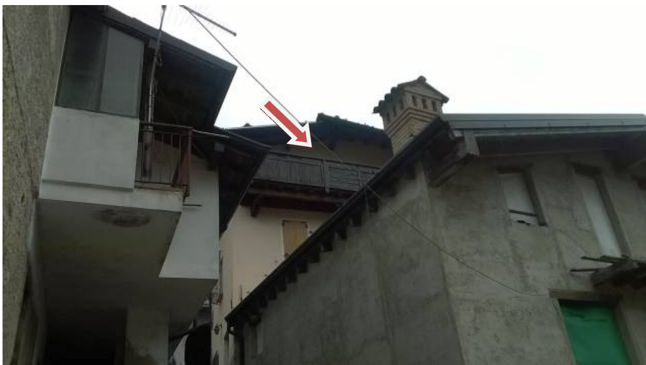
La freccia indica il balcone in legno abusivo
