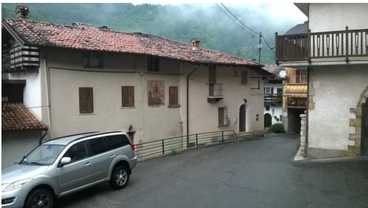
Vista Ovest balcone in legno abusivo
